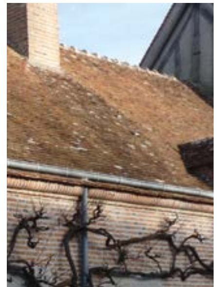
Nantaise – en V – sur ardoise et havraise – demi-ronde – sur tuiles plates.
