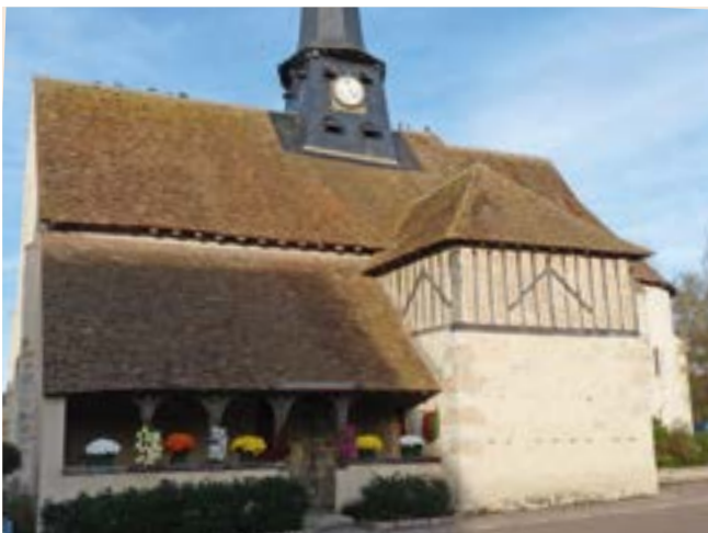
Caquoire et pan de bois avec remplissage de briques en fougère caractérisent l'église d'Isdes, récemment restaurée.
