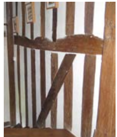
Enduit chaux (CL90) au ras des poteaux. C'est cette pratique qu'il convient d'adopter.
