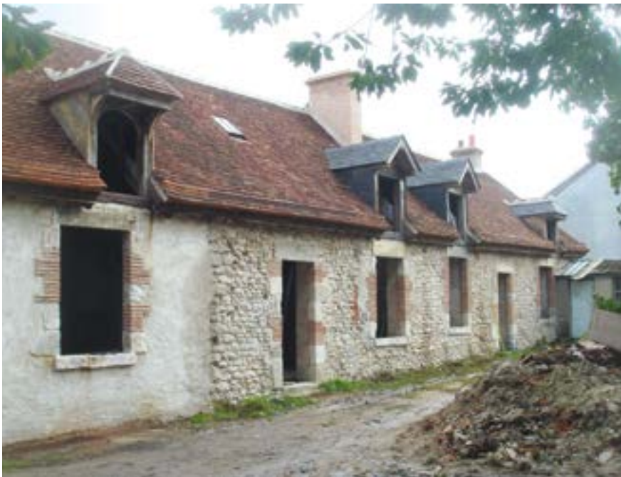
Chantier en cours
