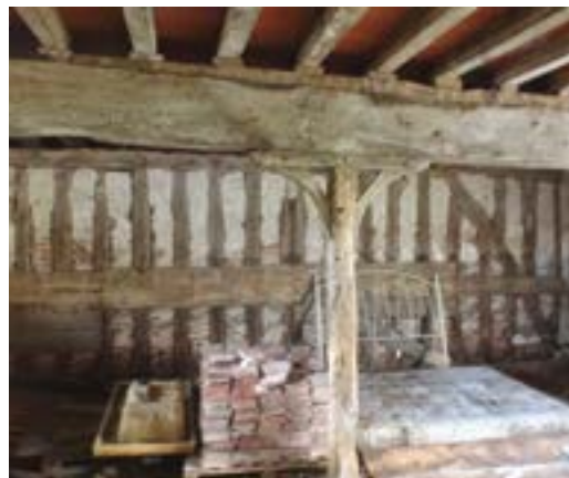
Pan de bois avec hourdis de brique ou de torchis :
