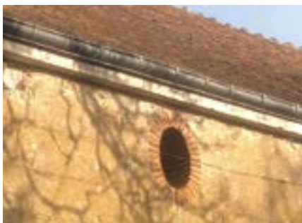
Corniches en pierre (Petite Beauce, ferme), pierre moulurée (maison de bourg), brique (Val-de-Loire)
