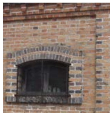
Brique de 5, joints fins.
