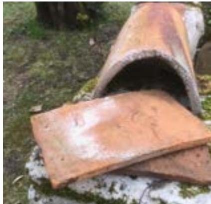
Tuile faïtière ancienne, pas tout à fait demi-ronde, mais évasée. La courbure de la tuile « plate », due aux procédés manuels de fabrication et de séchage, donne vie à la toiture.
