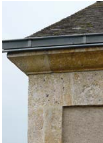
Nantaise – en V – sur ardoise et havraise – demi-ronde – sur tuiles plates.
