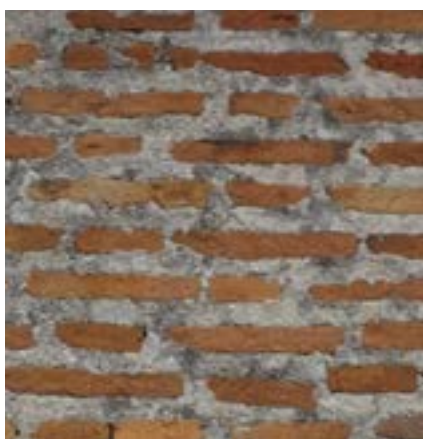
Brique de 3, joints épais.
