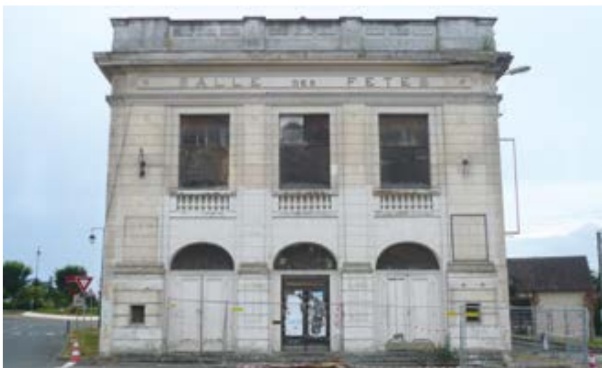
Salle des Fêtes de Courtenay (aujourd'hui détruite) : la démolition a mis en évidence la présence du plâtre dans la modénature et le système constructif du bâtiment.
