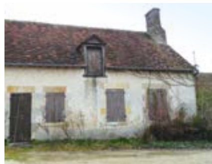
Maison de bourg plus modeste à Loury, très proche d'un logis de ferme : lucarne en bois, couverture en tuiles, porte sans imposte.
