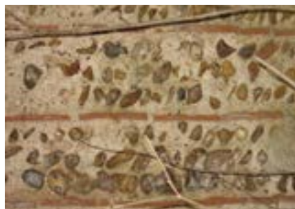
Maçonneries de silex à Tigy.
