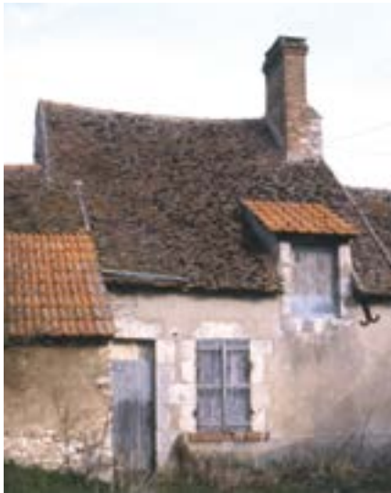
Réparation en tuiles mécaniques.
