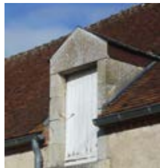
Jouées en planches sur lucarne en bois et en pierre dans la continuité du jambage.
