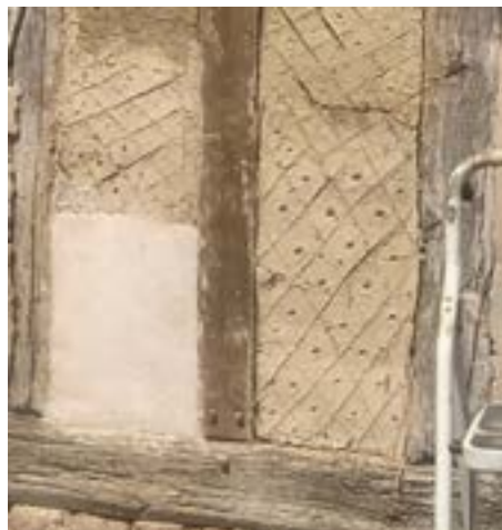
Enduit chaux (CL90) au ras des poteaux. C'est cette pratique qu'il convient d'adopter.
