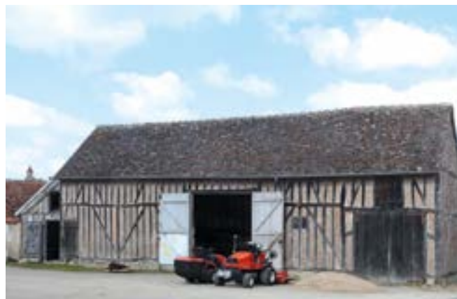
Grange à Dry.
