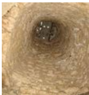
Puits d'extraction d'une cave-carrière à Mareau-aux-Prés.
