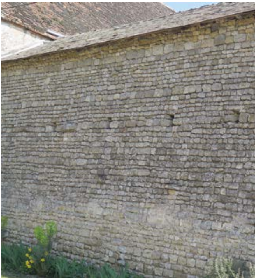
Mur de Beauce en moellons non enduits car de bonne qualité, équarris et assisés.
