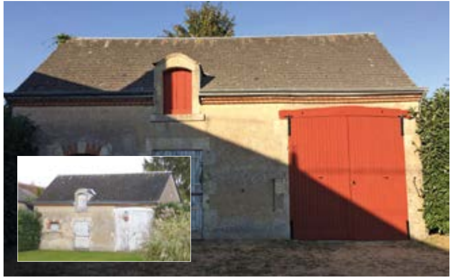
Ci-dessus (avant/après), peinture à l'ocre et à la farine sur résineux à Trainou.
