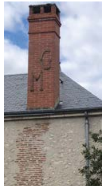
Souche de cheminée en briques de 5. Conduit maçonné en briques de 3.
