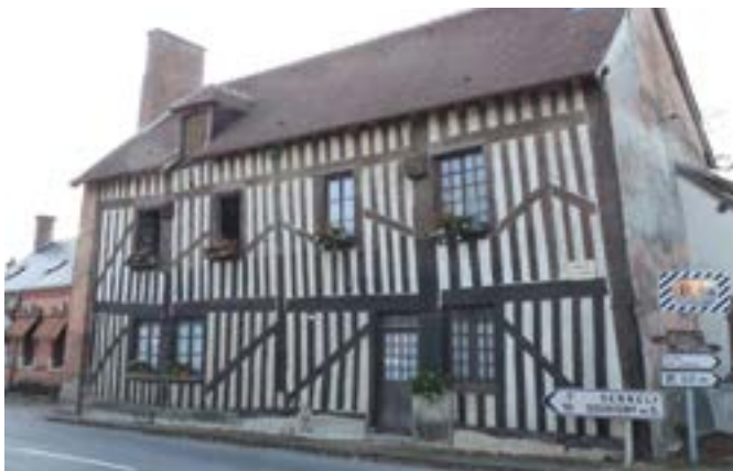
A Vannes-sur-Cosson, ancienne auberge en pan de bois à 3 niveaux.
