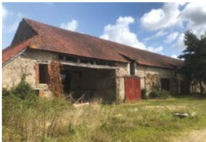
Maçonnerie de silex et encadrements de brique.
