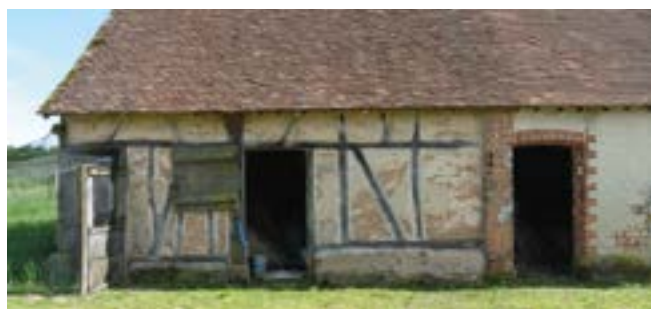
Hangar 19 e siècle en Forêt d'Orléans, à la structure bois nettement allégée.
