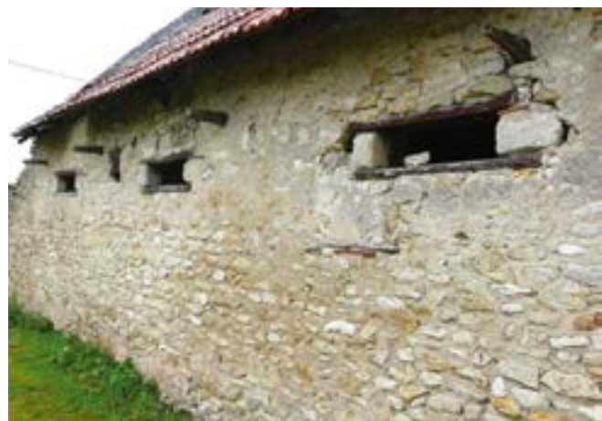
Maçonnerie de moellons.
