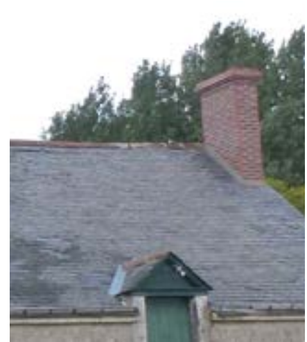
Couverture en ardoise avec faîtage en tuiles (Petite Beauce).
