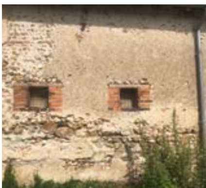
Maçonnerie de silex et encadrements de brique.
