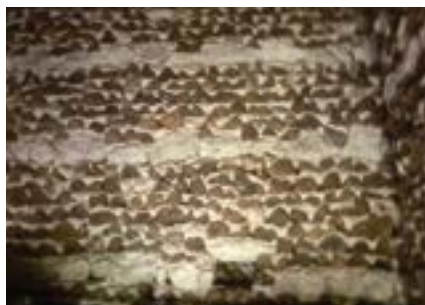
Intérieur d'appentis à Germigny-des-Prés.
