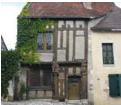
Encorbellement et poteaux sculptés sur une maison de bourg à Ouzouer-sur-Trézée.
