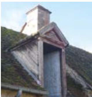
Jouées en planches sur lucarne en bois et en pierre dans la continuité du jambage.
