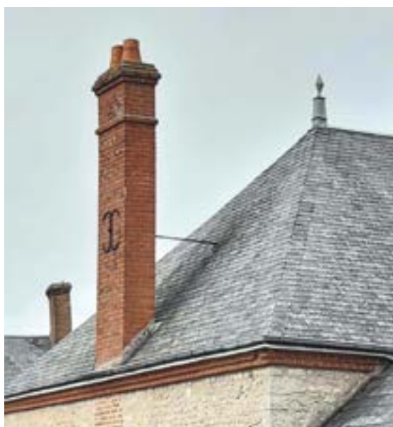
Souche en briques de 5 maintenue par un tirant métallique.
