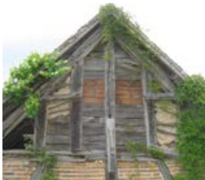
Torchis sur pignon protégé par bardage bois.
