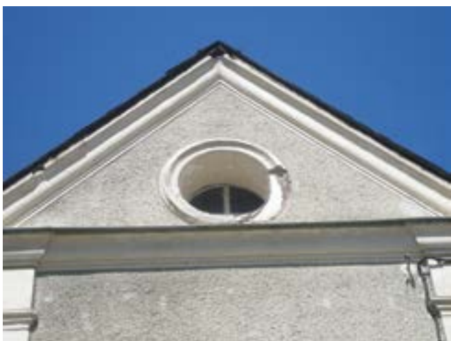
Châtillon-Coligny : corniche, pilastres et entourage de l'œil de bœuf en « plâtre gros ».
