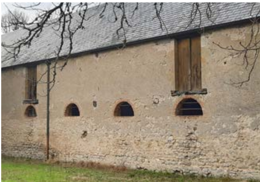
Enduit complètement couvrant à l'origine. L'effet « pierres vues » n'est dû qu'à l'usure de l'enduit en bas des murs.
