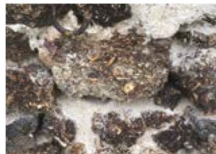
Poudingue : conglomérat de silex utilisé en Val-de-Loire Est et en Berry.
