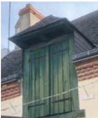
Lucarne à croupe (« à la capucine ») avec avancée pouvant recevoir une poulie.
