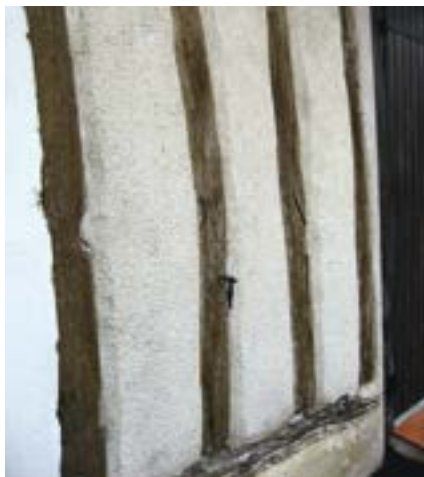
Enduit en surépaisseur avec un effet « doudoune ».
