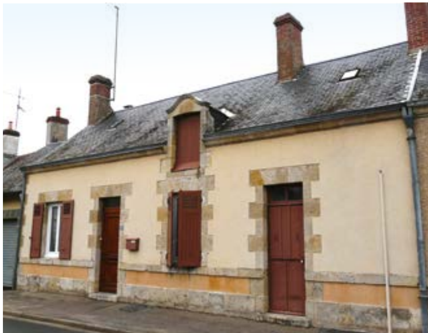
Maison de bourg à Vitry-aux-Loges : lucarne pierre en chapeau de gendarme, bandeau de pierre, volets un tiers persiennés, imposte, symétrie parfaite des ouvertures, couverture en ardoise.
