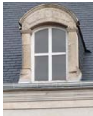
Ci-contre: sur les maisons bourgeoises, les lucarnes ont une fonction d'éclairément des pièces de l'étage et sont vitrées dès l'origine.
