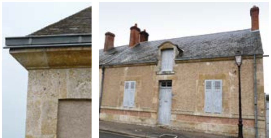
Pierre de Fay employée dans maison de bourg à Vitry-aux-Loges pour encadrements, bandeau, soubassement et corniche.
