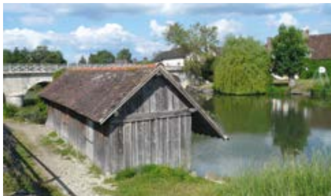
Lavoir en bois, bardé de planches verticales brutes avec couvre-joints.
