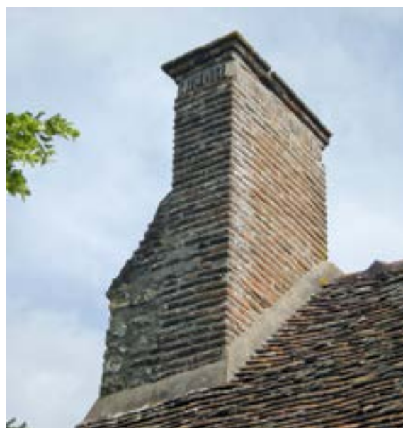
Souche en briques de 3, avec épaulement ou renvoi d'eau qui permet d'éloigner l'eau du mur pignon.
