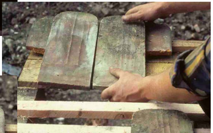
Un second rang de tuiles est accroché à la planche d'égout, sur lequel est posé un troisième rang, à joints croisés.
