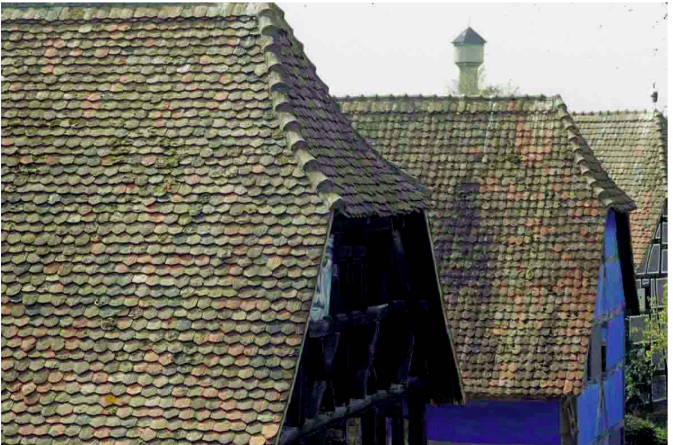
Ecomusée d'Ungersheim (Haut-Rhin), 2003. au premier plan, mode de couverture double ; au deuxième et au troisième, mode de couverture simple.
