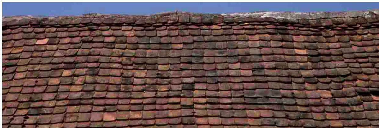
Bosselhausen (Bas-Rhin), 1994, le rang de tuiles le plus haut est doublé.
