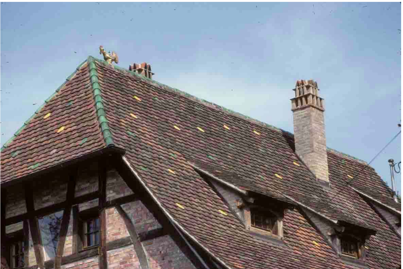
Carspach (Haut-Rhin), 1999, quelques tuiles vernissées, notamment en arêtier.
