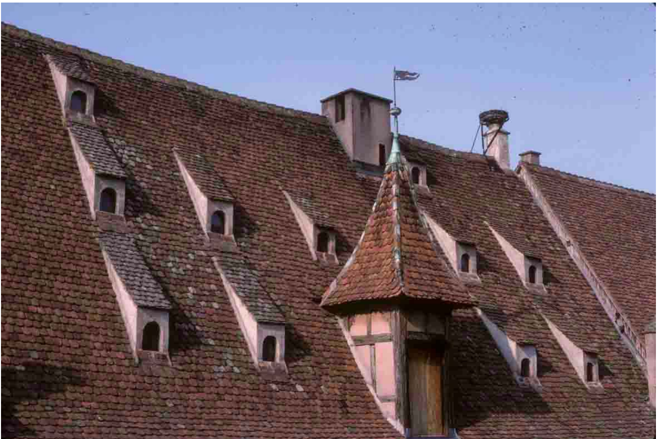
Obernai (Bas-Rhin), 1998, toiture urbaine avec un clocheton et de gracieuses lucarnes de ventilation.
