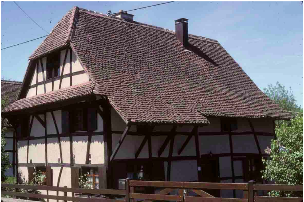
Hundsbach (Haut-Rhin), 2002. Avec cet auvent, la toiture se porte en pignon.
