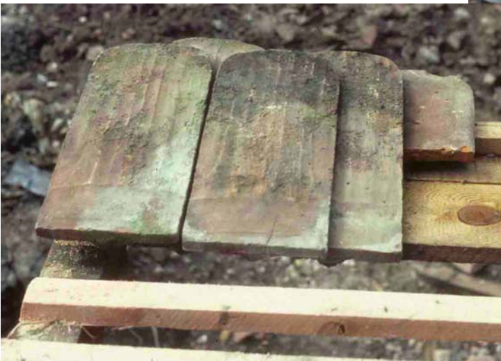
Un second rang de tuiles est accroché à la planche d'égout, sur lequel est posé un troisième rang, à joints croisés.
