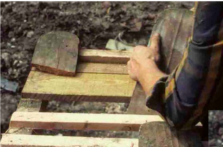
Pour commencer, pose d'une demi-tuile clouée sur la planche de rive, légèrement redressée par une latte. Bisping (Moselle), 1980
