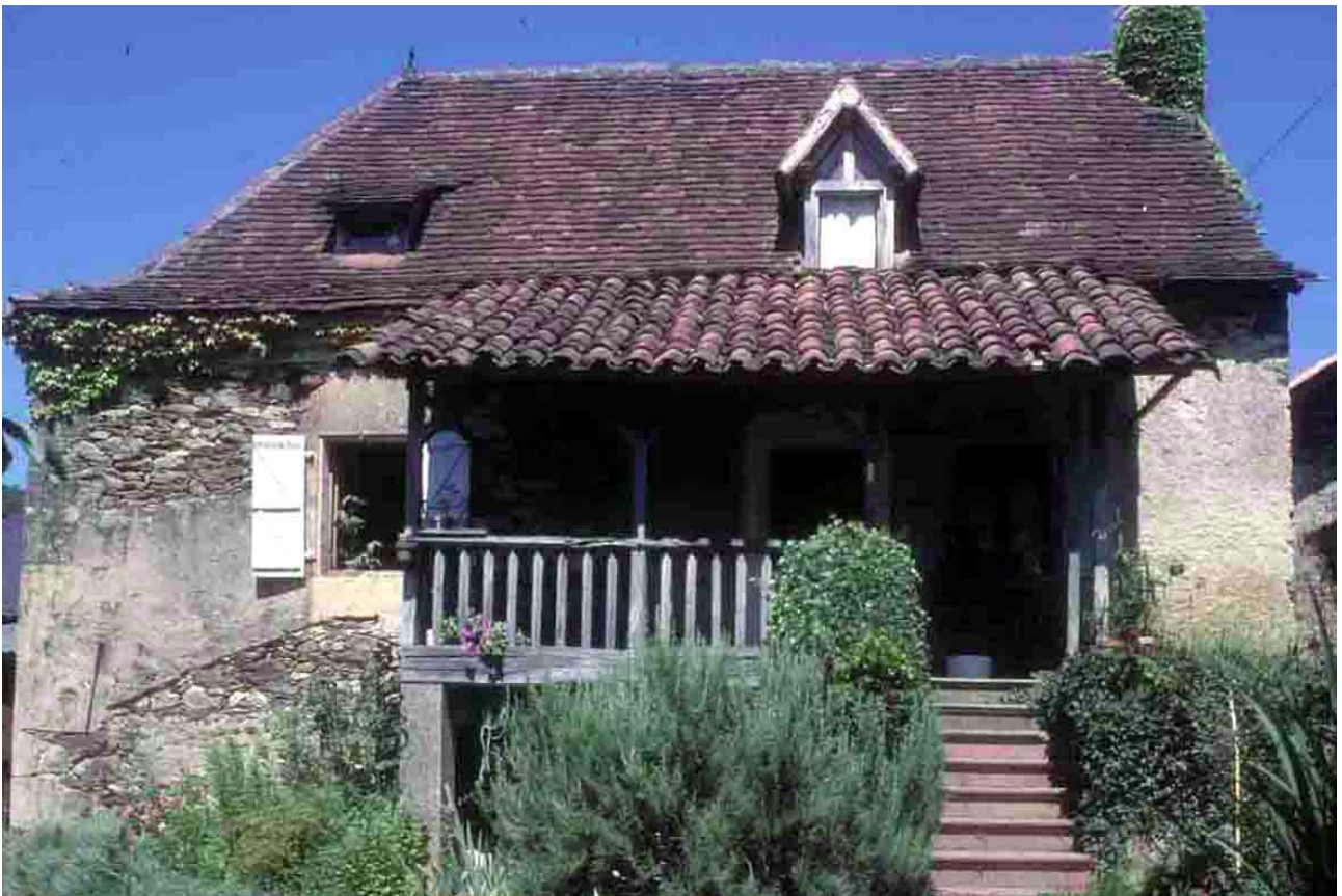
Ladirat Costeplane (Lot), 1999. le coyau reste en tuiles plates mais l'auvent est en tuiles canal.
