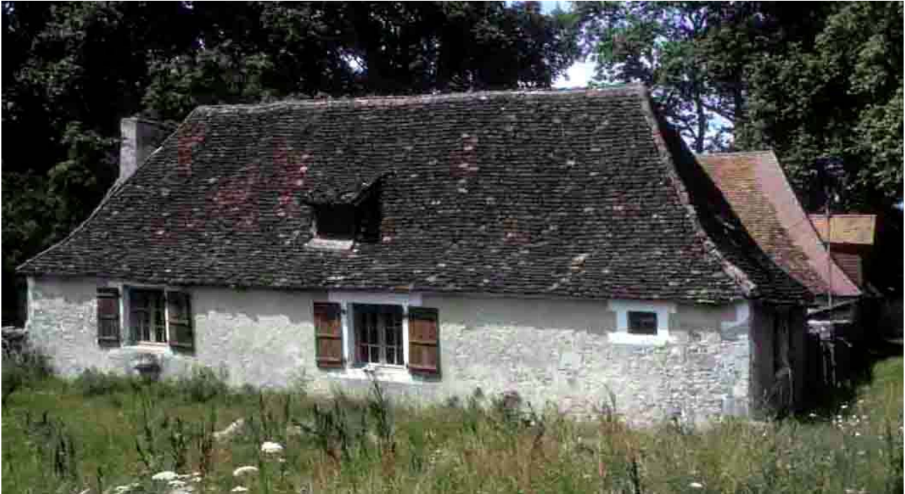
Ajat le Puy (Dordogne), 1992. Avec ce modèle de toiture, le coyau prend haut sur l'arête de la croupe.
