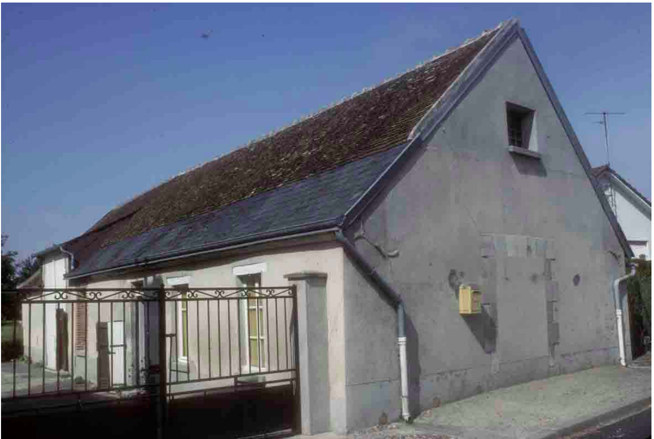
Attray (Nièvre), panachage entre l'ardoise et la tuile plate.
