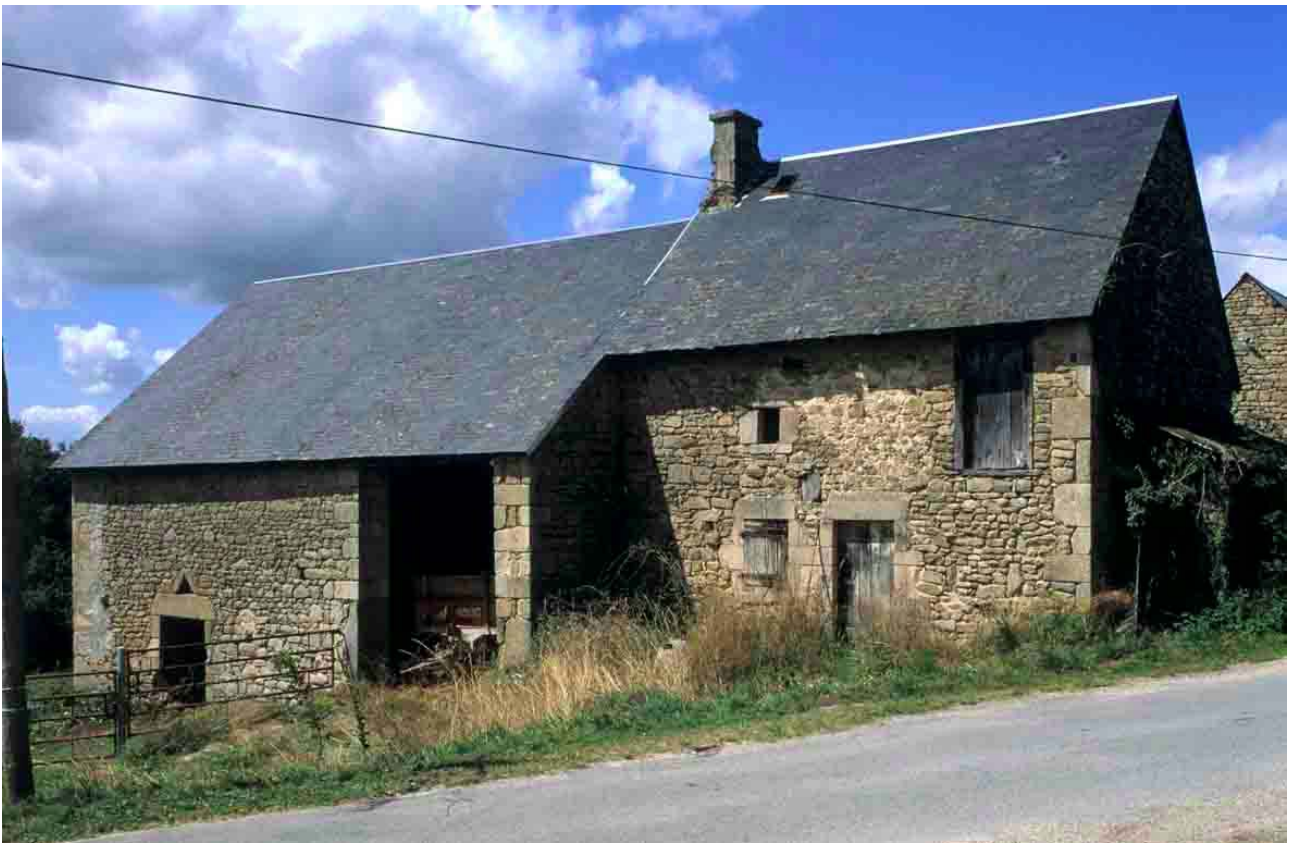
Châtenet-le-Vieux (Creuse), 2013. Une seule fausse note ; la faîtière en zinc.
