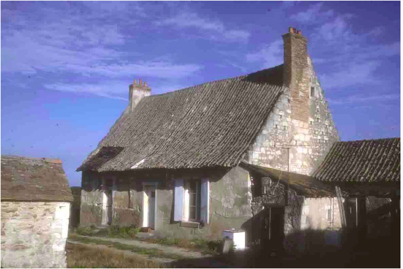
Les Airau (Maine-et-Loire), 1988. Un toit de pente particulièrement forte.
