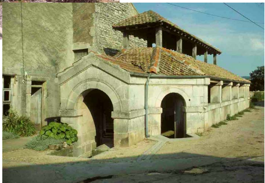
Taillancourt (Meuse), 1977. un véritable lavoir de style, couvert de tuile violon, avec un toit à lanterneau porté par dix poteaux de bois.
