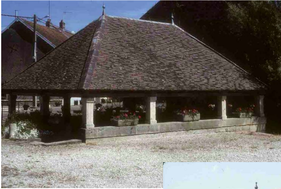
Batrans (Haute-Saône), 2003. Ces arêtières en zinc sont regrettables, au regard de la beauté de cette toiture en tuile plate. On s'interroge sur les raisons qui ont conduit les communes à s'offrir des lavoirs aussi précieux. Qui plus est, des édifices à usage féminin, à une époque où les femmes avaient peu à dire de la vie communale.
