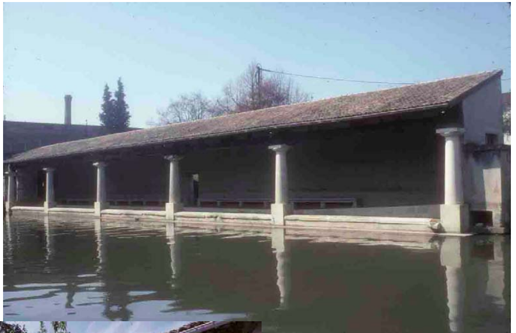
Gondreville (Meurthe-et-Moselle), 2002. un grand lavoir urbain, à toit d'un seul pan, peu incliné, porté par six piliers de pierre. La lessive se faisait directement dans la Moselle.
