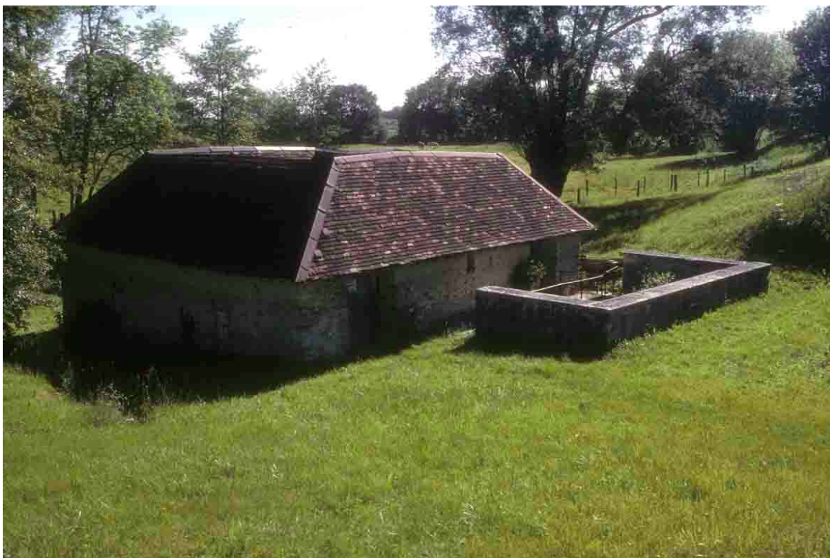
Dans l'Aube, avec son abreuvoir attenant, la lavoir de Poligny est de type pluvium, c'est-à-dire qu'il est alimenté par les eaux de pluie. 1997
