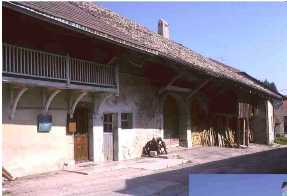
Le Brey (Doubs), 1998. En Franche Comté, plus de poteaux, dans cet exemple, le large auvent de la toiture repose sur les consoles qui portent une sablière extérieure, sur laquelle les chevrons permettent à la toiture de déborder aussi fortement.
