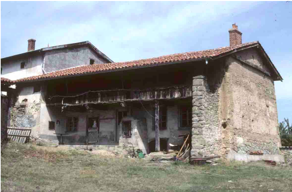
Ailleux (Loire), 2003, du pisé, toujours, une galerie, encore, mais cette fois-ci en bordure des Monts du Lyonnais. La galerie prend le nom d'aîtres.
