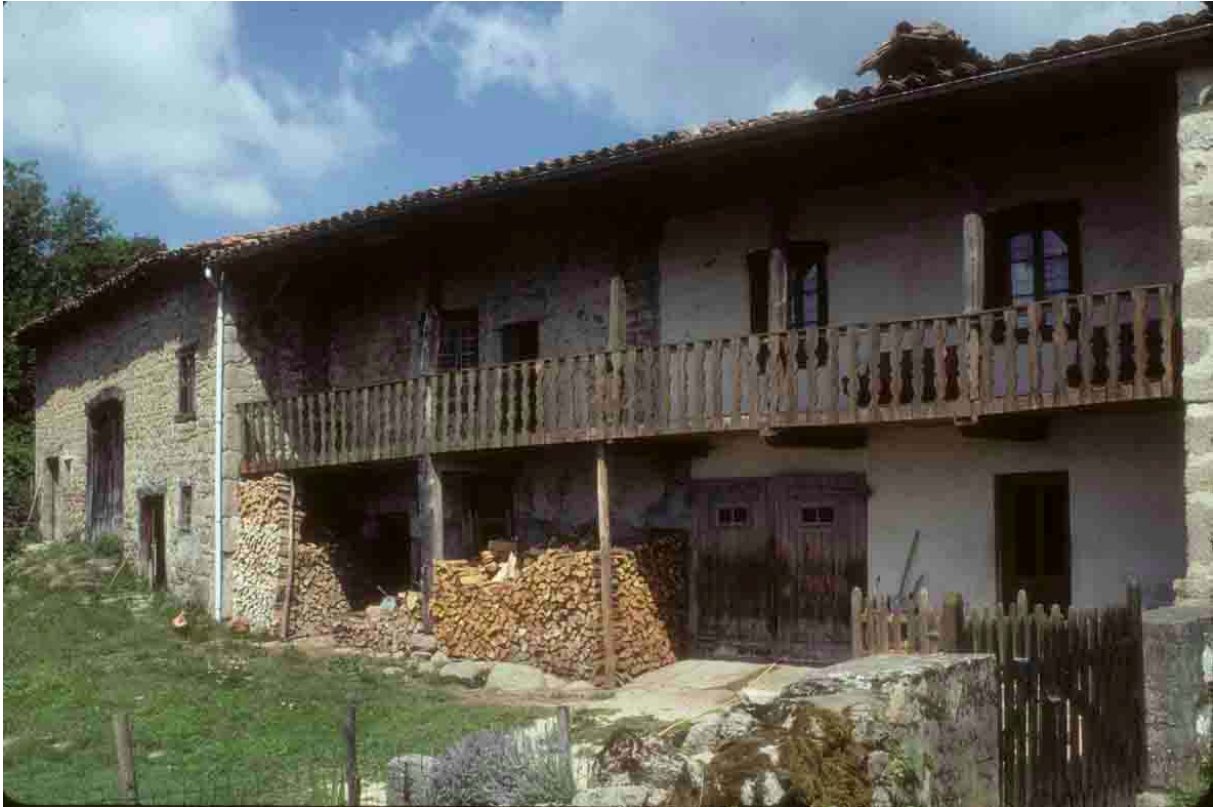
Les Ronzières (Loire), 2009. encadrée par les pignons, cette galerie dessert toute la longueur du logis. La balustrade est faite d'une planche sur deux ; elle peut être de bois plein.
