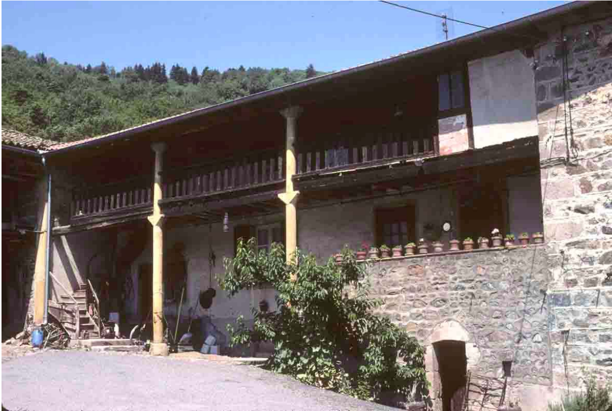
Saint-Julien-Bibost, le Fraissonet (Rhône), 2004 et 2006. Un escalier tournant conduit à une vaste galerie d'étage, superbement portée par deux fins piliers de pierre à deux fois doubles consoles. La balustrade est faite à claire-voie. La recherche de la beauté et de l'élégance paraît évidente.
