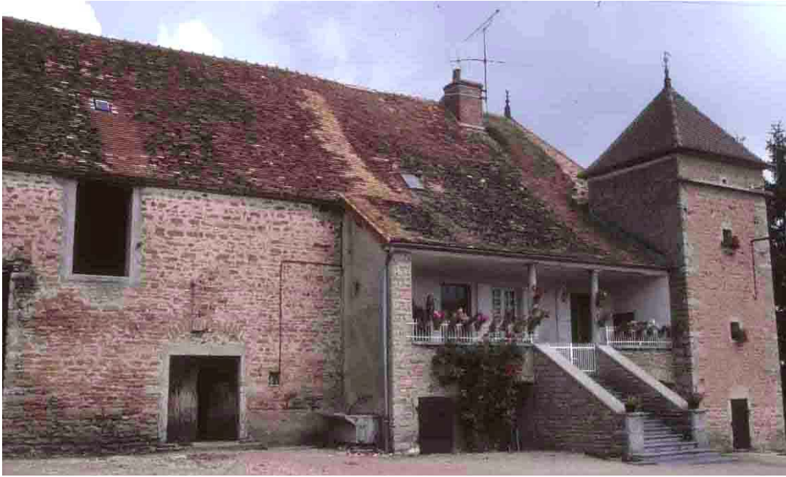
Chavagny (Saône-et-Loire), 1987, la galerie peut s'accompagner d'un pigeonnier, autre signe de représentation sociale. La toiture, à forte pente et couverte de tuile plate, est prolongée par l'auvent de la galerie qui se dispose en coyau.
