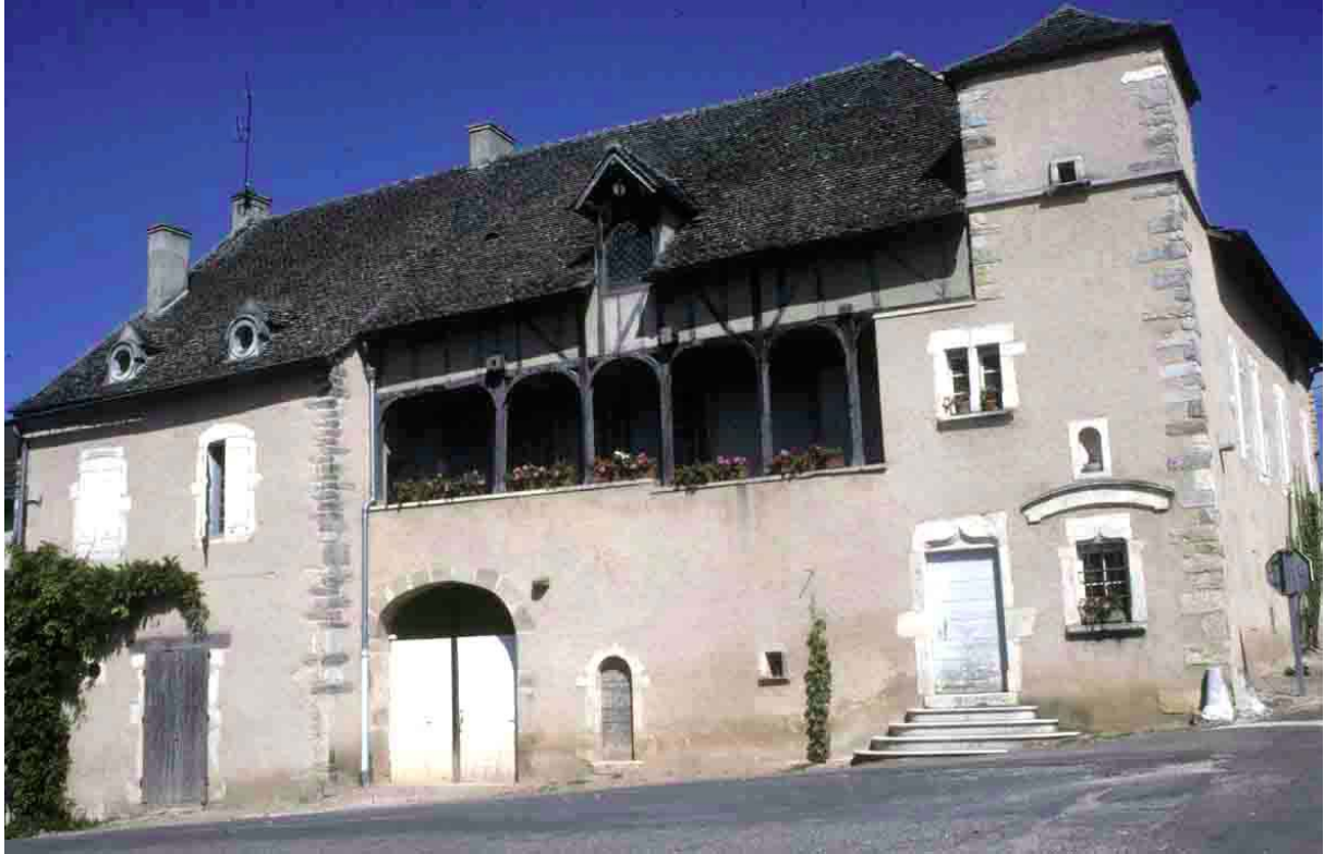
Jambles (Saône-et-Loire), 1997. accolades et fenêtres géminées : cette maison a de l'histoire. Surmontés d'un pan de bois, les poteaux de la galerie sont en bois, avec des aisseliers courbes, ce qui la rend cohérente avec les ouvertures du pigeonnier : XV e ou XVI e siècle ?
