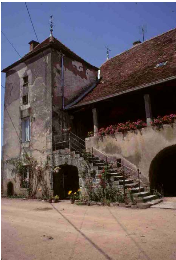
Saint-André-le-Désert (Saône-et-Loire), 2001, grande galerie accotée à un pigeonner massif, sous un toit de forte pente, qui rehausse le caractère prestigieux de l'ensemble. L'escalier extérieur sert d'articulation entre les deux bâtiments. Il donne accès au logis, à l'étage, desservi sur toute la longueur de la façade. Le toit de la galerie forme un coyau très ample.
