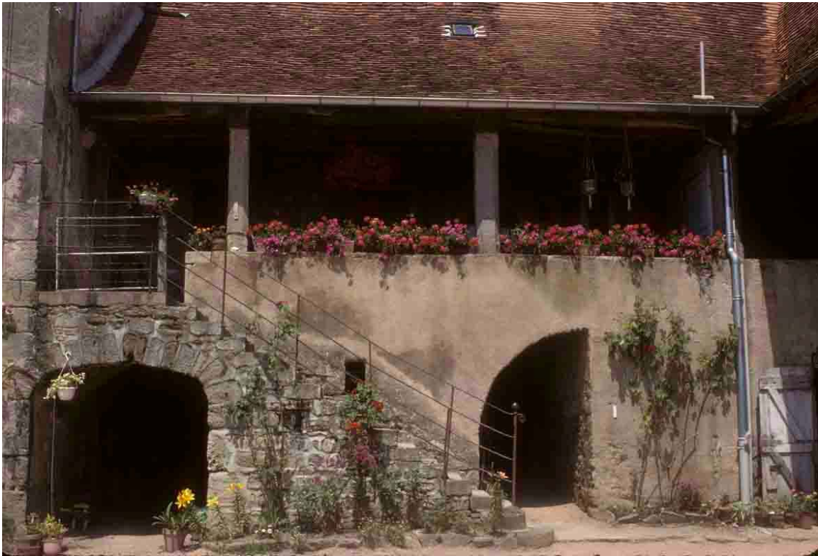
Saint-André-le-Désert (Saône-et-Loire), 2001, grande galerie accotée à un pigeonner massif, sous un toit de forte pente, qui rehausse le caractère prestigieux de l'ensemble. L'escalier extérieur sert d'articulation entre les deux bâtiments. Il donne accès au logis, à l'étage, desservi sur toute la longueur de la façade. Le toit de la galerie forme un coyau très ample.
