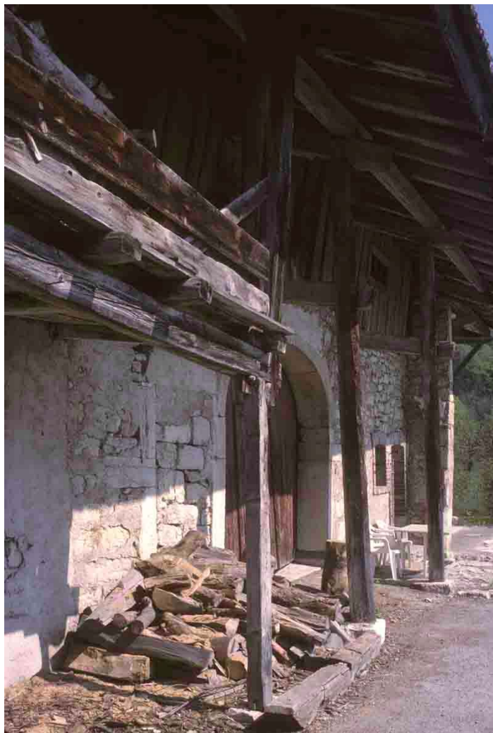
Dans le Val de Mouthe, la création de la galerie adopte le même procédé, avec une largeur de débordement du toit. Celui-ci s'appuie, mais pas toujours, sur des poteaux à galerie ouverte, sans muret protecteur. Ces poteaux permettent la mise en place d'un balcon destiné à stocker le bois de chauffage..
