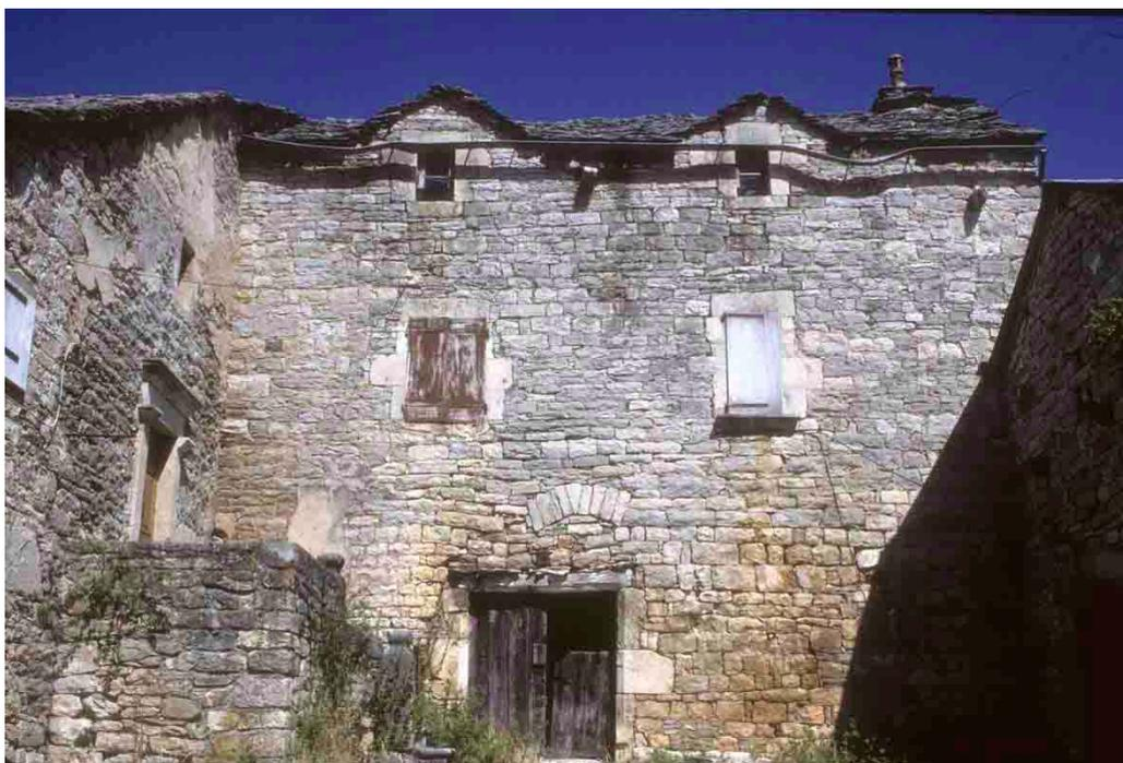
*Le Tieule (Lozère), 1994. la maison typique des grands causses, qui ne laisse de place au bois que pour les chambranles de porte et les châssis de fenêtres.*
