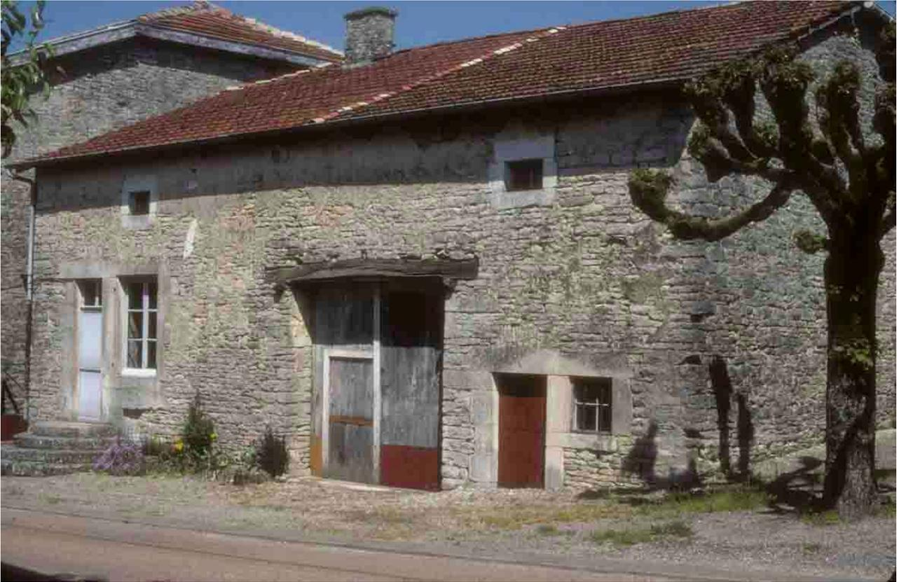
*Ambonville (Haute-Marne), 2004. la perte de son enduit, assez fin, révèle une maçonnerie faite de petits moellons, réguliers et serrés, aptes à rester nus.*
