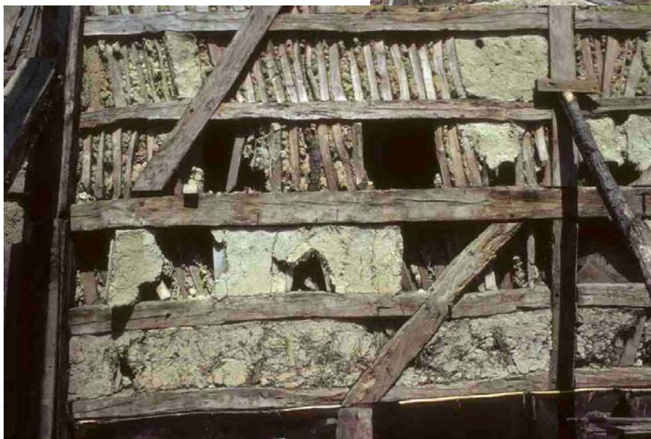
*Passavant-en-Argonne (Marne), 1982. Un véritable écorché de pan de bois. Les éclisses sont posées serrées légèrement en biais. Une fois comprimé, le torchis est recouvert d'un enduit, lui-même protégé par un lait de chaux.*
