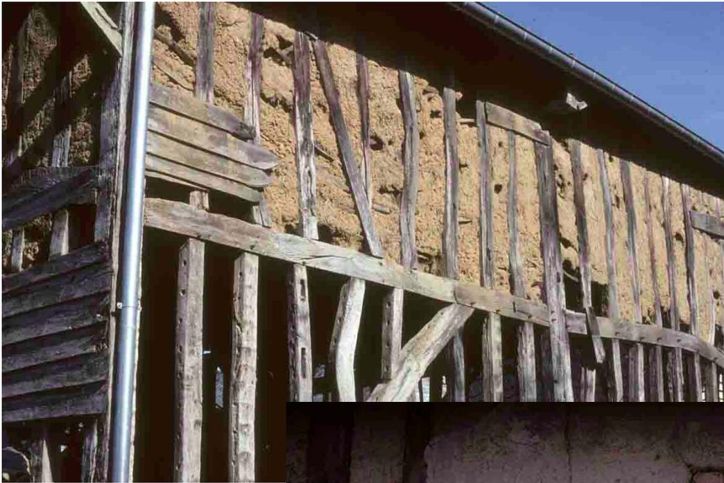
*Coutenval (Aisne), 2005, pan de bois serré, le torchis est appliqué sur des étrésillons assez rapprochés ; il est ensuite protégé par un bauchage constitué de planches horizontales posées légèrement à clin, dont on observe des traces sur la gauche.*
