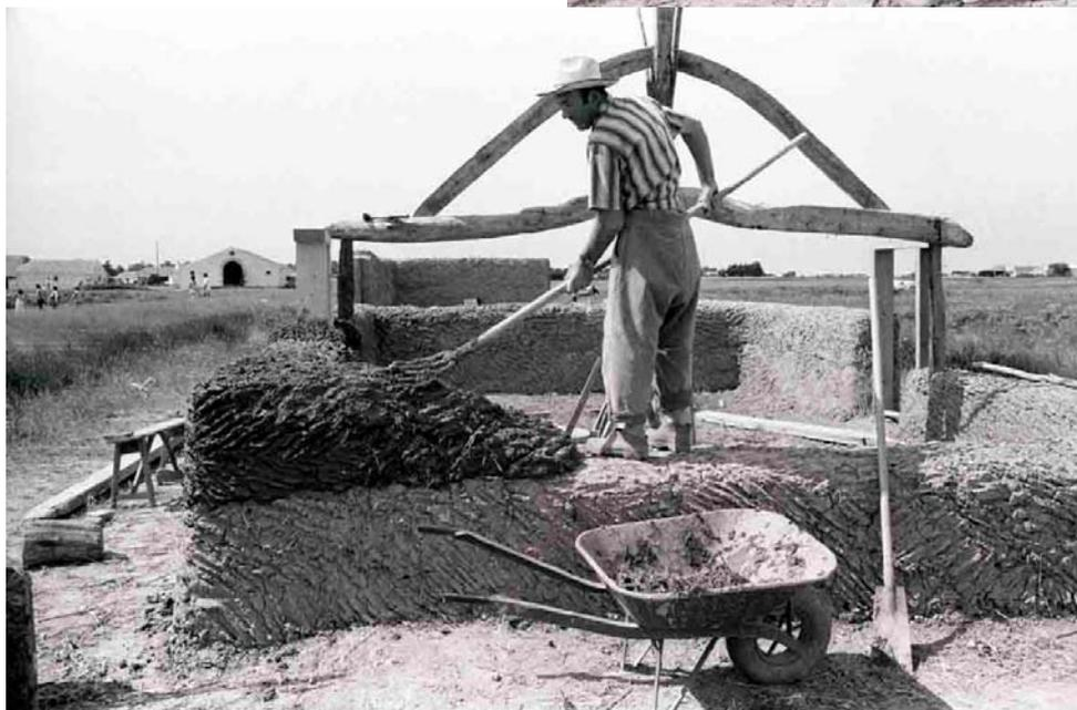
*A l'avant plan, un aide préparer la bauge, constituée d'argile et de terre, que le maçon applique par niveaux, à raison de hauteurs de 50 cm environ.*
