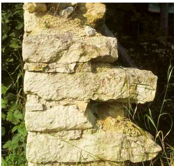
*Barisey-la-Côte (Meurthe-et-Moselle), 1977, les liants en terre donnent aux maçonneries de la souplesse et une excellente cohésion. Ils permettent, au besoin, un emploi facile des moellons.*
