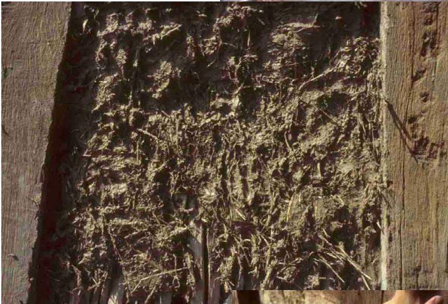
*La terre doit être appliquée sur le clayonnage, des deux côtés en même temps.*
