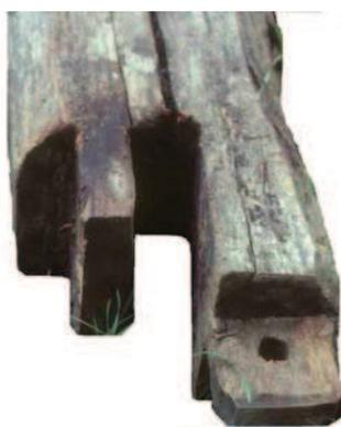
sûr le couple tenon mortaise, avec cheville, lorsqu'une pièce s'inscrit par ses extrémités dans une autre. Lorsque deux pièces se croisent, une entretoise et une décharge, par exemple, elles s'assemblent à mi-bois, sans cheville. Les assemblages entre les poteaux et les sablières prennent forme d'enfourchements grâce auxquels deux sablières perpendiculaires peuvent se superposer sur un même poteau. Les traits de Jupiter, avec cheville, permettent de relier deux pièces horizontales alignées.
