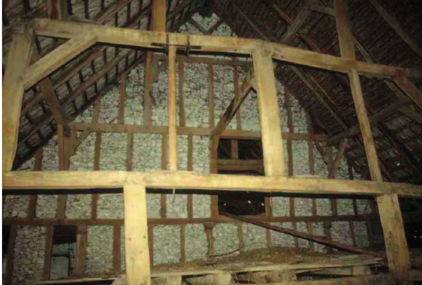
Diffembach-les-Hellimer (Moselle), 1991. dans la même maison, deux fermes à reprises de forces verticales, constituées d'entraits et de potelets, fermée entre le logis et le corps d'exploitation, ouverte entre la grange et l'écurie la plus extrême. D'un côté, elle sert de coupe-feu ; de l'autre, elle permet de passer le fourrage.
