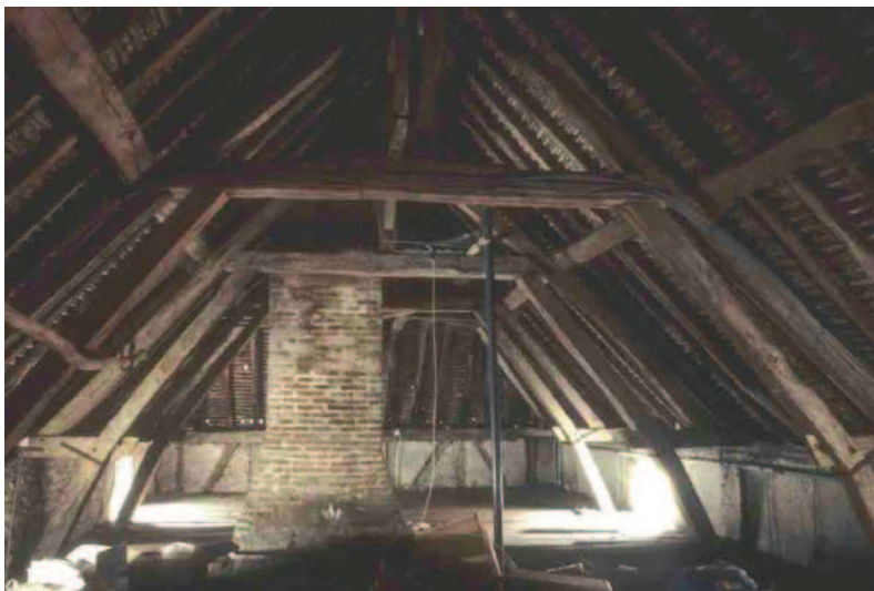
Pagny-la-Ville (Côte d'Or), 1992, charpente à surcroît, avec arbalétriers repris par des sous-arbalétriers, par l'intermédiaire de blochets
