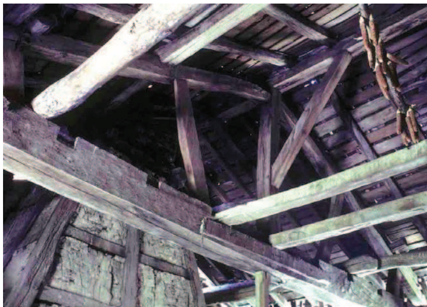
Courtes la Forêt (Ain), les toitures à faible pente acceptent des charpentes moins élaborées que les toitures à forte pente. Cette ferme se constitue d'un entrait de forte section, qui sert également de sommier de solives, d'un poinçon et de jambes de force destinées à soutenir les pannes intermédiaires.
