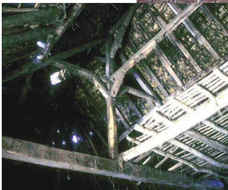
Saint-Eloi-les-Tuileries, la Rivière, 1996. Sous-faîtière, encore, ou lien de fermes, pour cette toiture de chaume. La ferme comporte un entrait de forte section, un poinçon et un entrait retroussé triangulé avec le lien de ferme et le poinçon.
