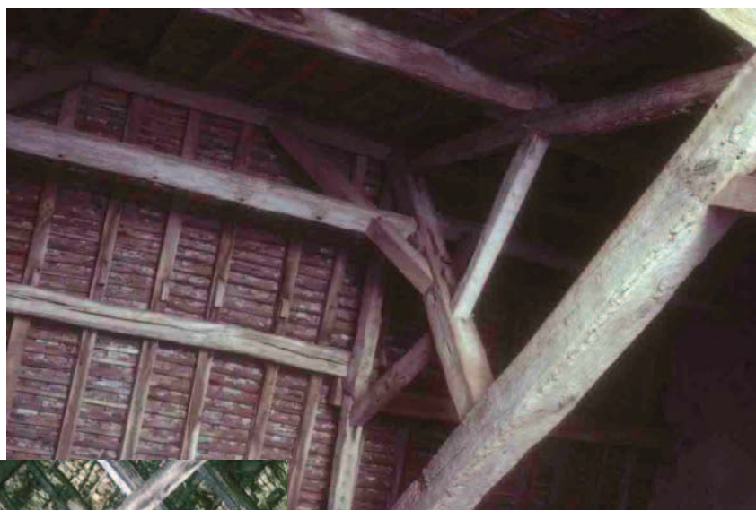
Neuvy (Loir-et-Cher), 1986, ferme rudimentaire constituée d'un entrait, d'un poinçon, de deux arbalétriers et de deux jambes de force reliant le poinçon aux arbalétriers. La panne faîtière se double d'une sous-faîtière.
