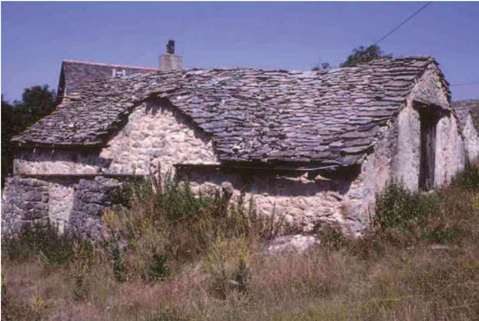
*Vallongues (Lozère), 1990. Un toit presque cruciforme. Les lucarnes typiques des maisons caussenardes permettaient d'augmenter la surface de captation des eaux assurée par le toit. La gouttière, visible à l'avant, acheminait l'eau vers la citerne.*
