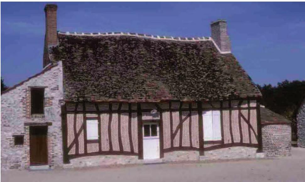
*Ligny-le-Ribault (Loiret), 1998, le pan de bois ne nécessite que des matériaux bruts seulement transformés par le travail de l'outil. Par contre, l'usage de briques en remplissage témoigne du passage du « cru vers le cuit » mais le matériau de base reste le même.*
