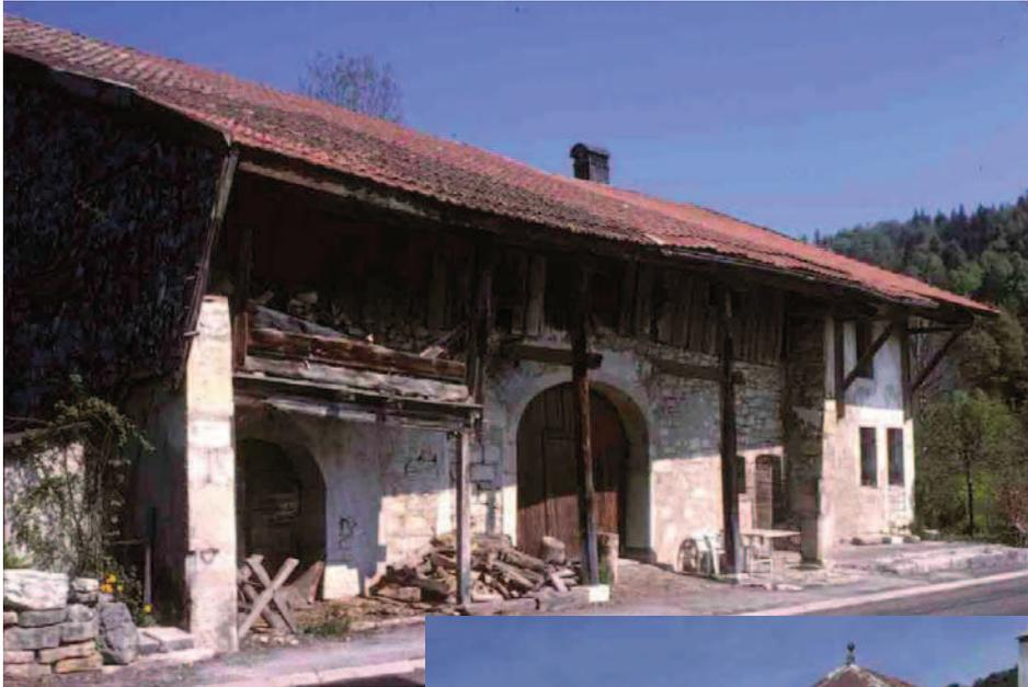
*Boujeons (Doubs), 1998, dans le val de Mouthe, les façades sont protégées de la pluie par l'auvent du toit, et du vent, par le débordement du pignon qui ferme la galerie sous poteau formée par l'avancée du toit.*
