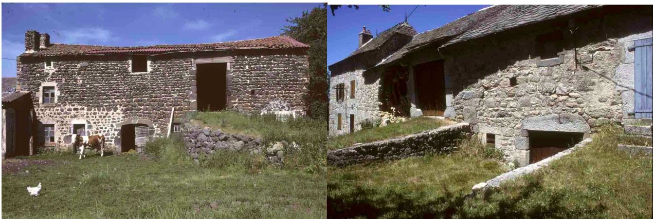
Aunac (Haute-Loire), 1985, et Aubigeyrette (Lozère), 1996. Ces maisons appartiennent toutes deux au type de la maison auvergnate à grange haute, avec pont de grange, mais elles sont localement distinguables, l'une à sa maçonnerie de basalte, son toit de tuile canal et son logis intégré ; l'autre à sa maçonnerie de granite, son toit de lauze et son logis associé.
