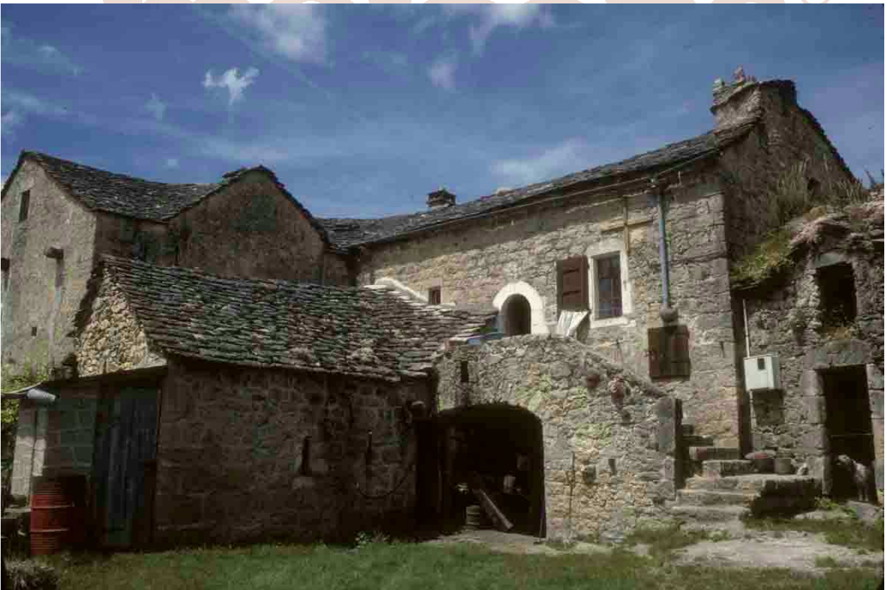
Saint-André-de-Veysines (Aveyron) sur le Causse Noir. La maison classique de base, en bloc en hauteur, comportant une bergerie au rez-de-chaussée et un logis à l'étage, reliés par un escalier extérieur, a fini par prendre un volume complexe grâce à l'ajout successif de corps de bâtiments, mais de façon harmonieuse.
