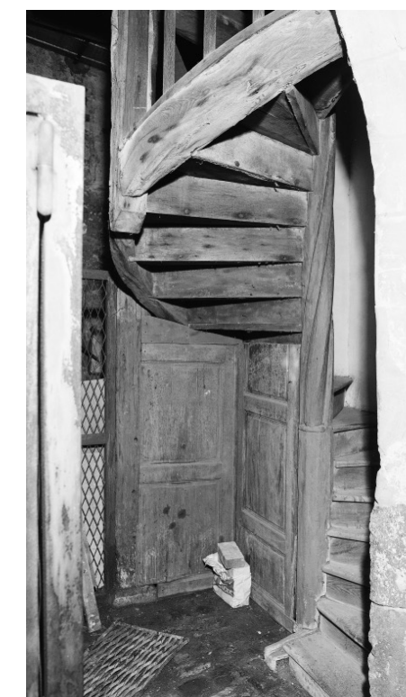
Escalier dans-œuvre, tournant à retours avec jour en charpente 5 rue Anatole France à Blois (41), XVIe siècle
