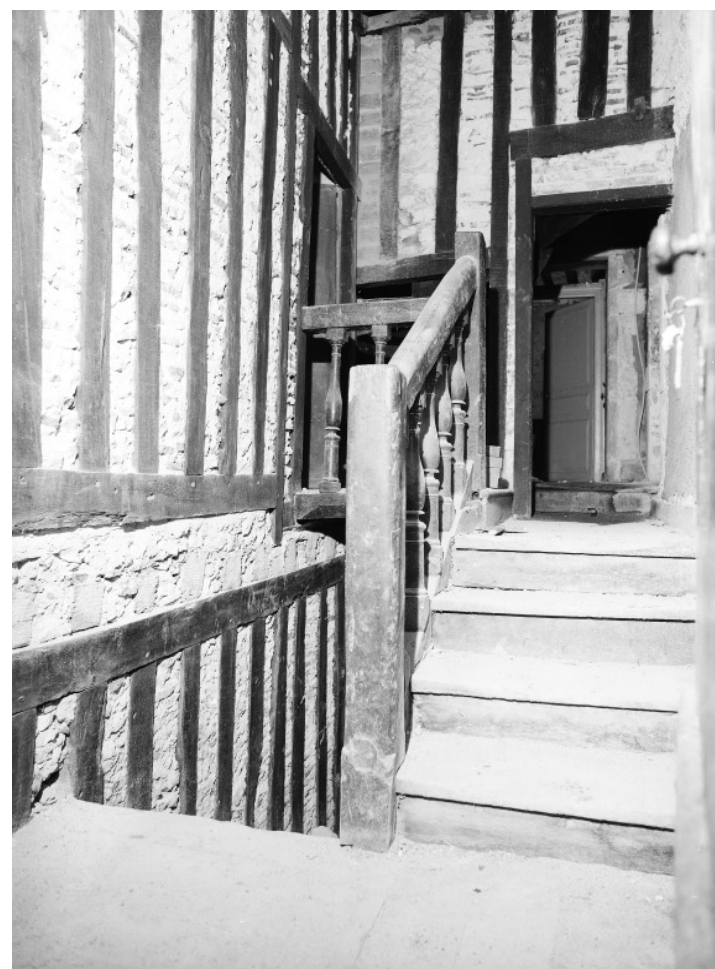
Escalier dans-oeuvre tournant à retours sans jour en charpente 7 rue Chemonton à Blois (41), fin du 4e quart XVIIIe s. / 1er quart XVIIIe s.
