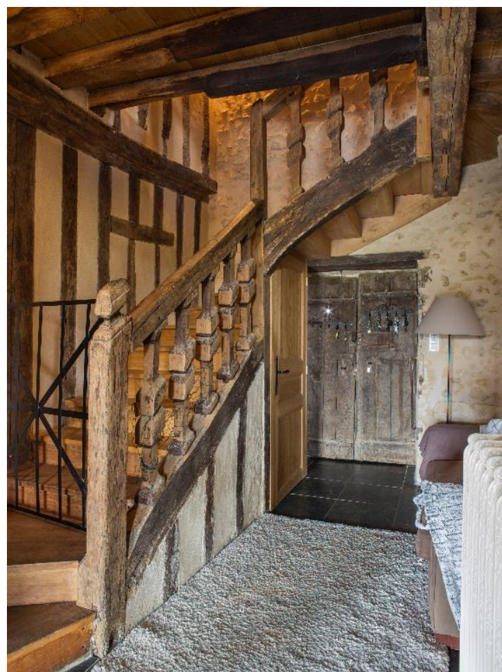
La tour renferme un escalier à deux quarts tournants, dont la montée est protégée par une balustrade en bois de style Louis XIV Manoir de Carcahut à Frazé (28), 4e quart XVIIIe siècle
