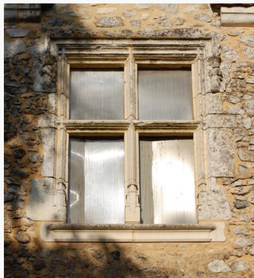
Réseau de nervures, et des corps de moulures prismatiques
