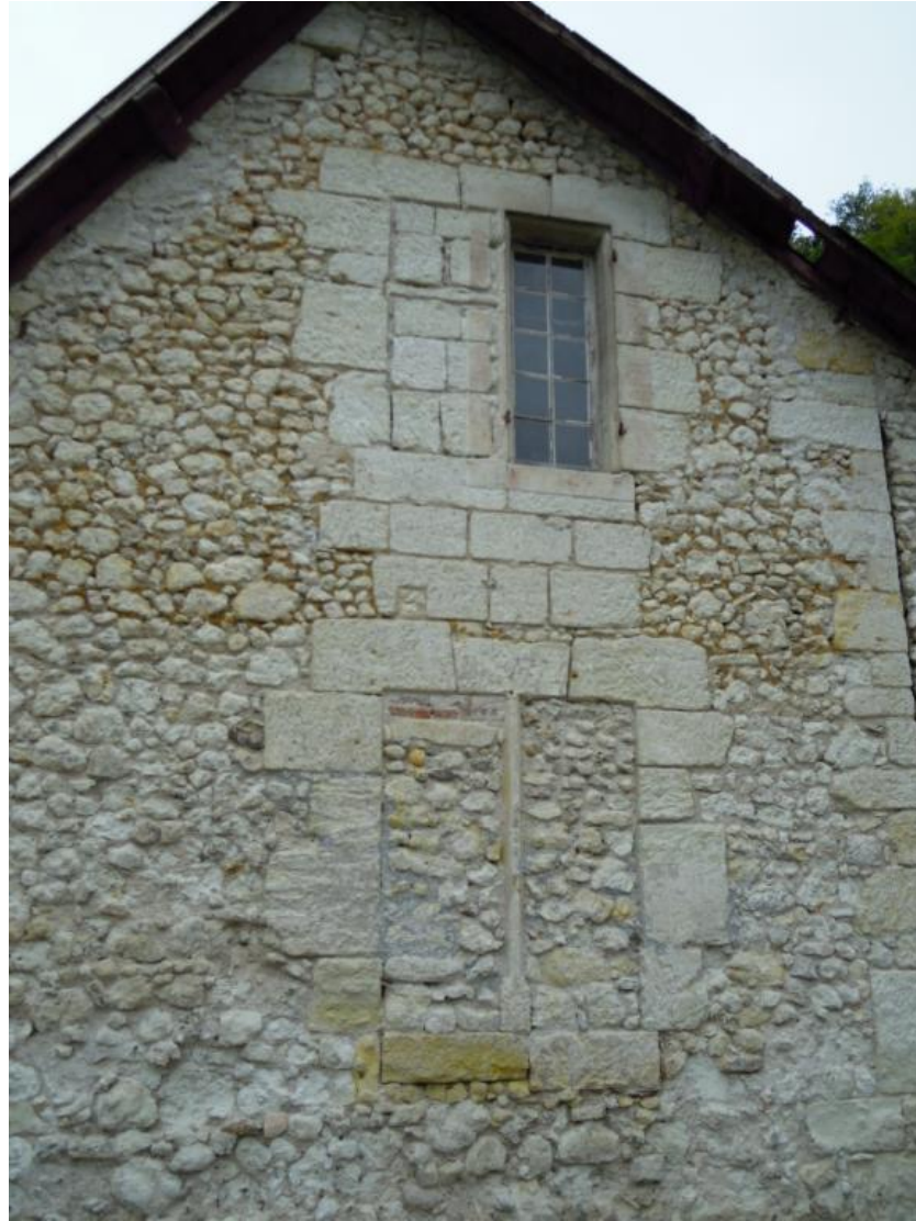
Bâtiment des communs, château dit l'Hôtel-Noble à Vernou-sur-Brenne (37), XVIe siècle
