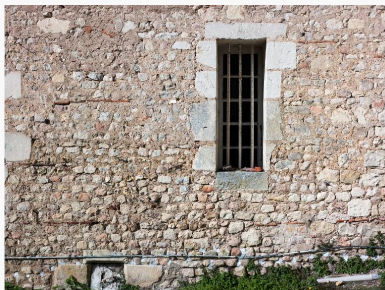
Ancien presbytère de Céré-la-Ronde (37), postérieur au premier quart du 16e siècle
