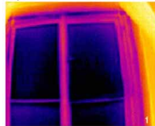
Thermographie d'une fenêtre simple vitrage
