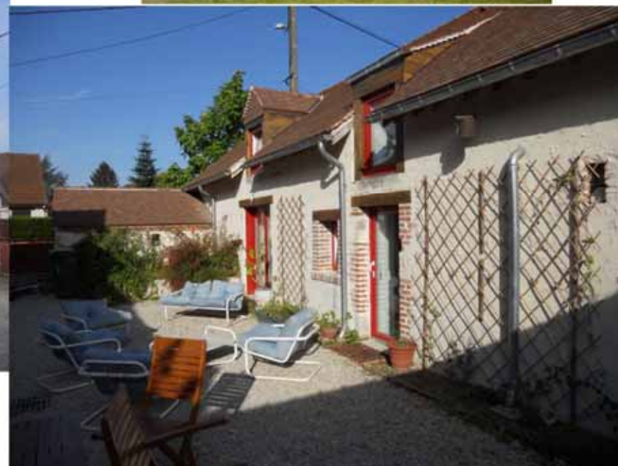
Façade Nord sur cour intérieure respectant le patrimoine (+ Isolation rapportée intérieure)
