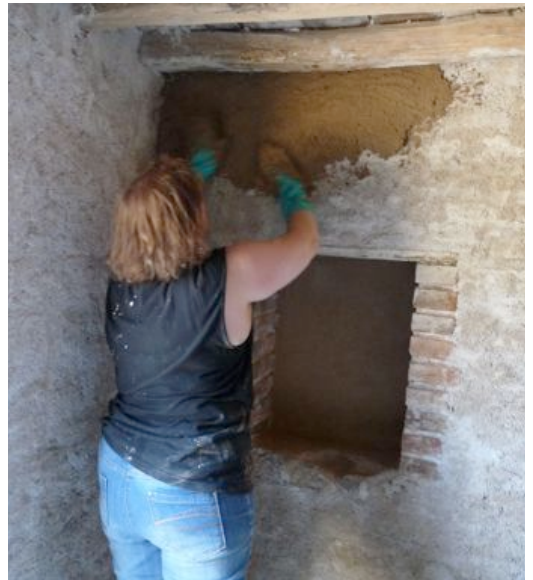
Application de la terre à la main sur le dégrossi
