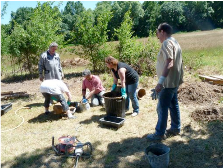
La préparation de la terre : extraction, tamisage, mélange
