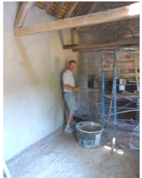
Enduits terre et chaux terminés sur 2 murs : rendez-vous est pris pour septembre afin de terminer les pignons et le mur restant
