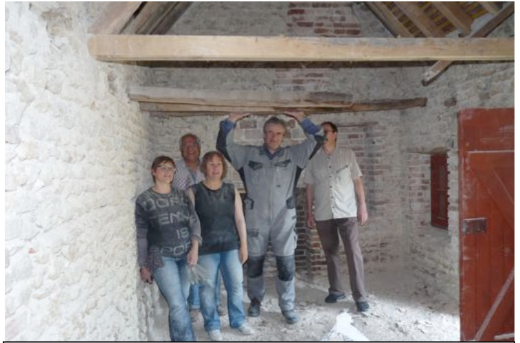
16h30 : fin du chantier ; tout le monde a travaillé d'arrache pied, le piochage s'est avéré plus vite fait que prévu
