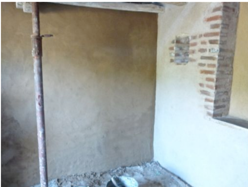
Enduits terre et chaux terminés sur 2 murs : rendez-vous est pris pour septembre afin de terminer les pignons et le mur restant
