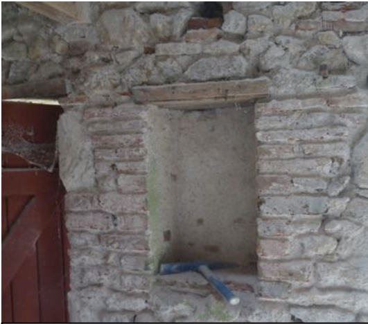
Les nombreuses niches existant dans la loge permettront de s'exercer au rejointoyage des briques
