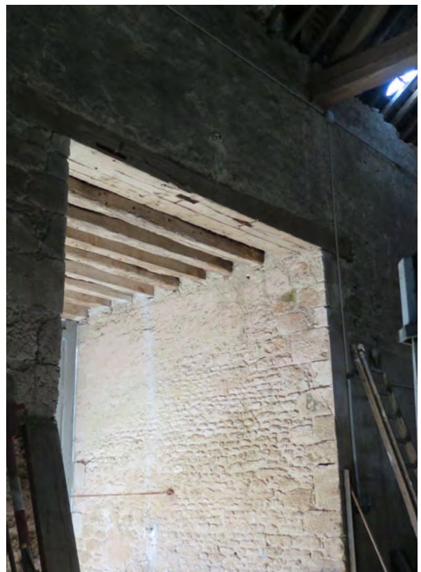
Porteau intégré dans la construction de la grange
