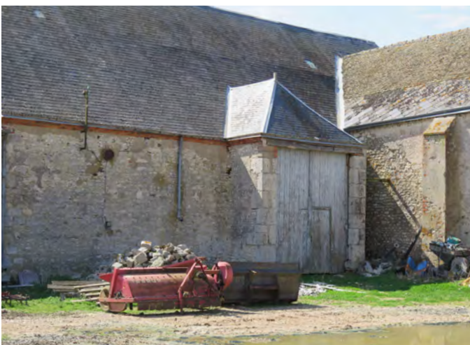
Grange de grande hauteur et porteau avec toit en croup
