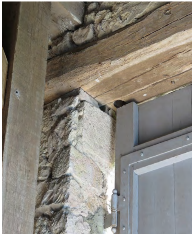
Montage d'ouverture de porte sous linteau droit
