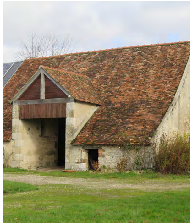
Porteau avec annexes accolées
