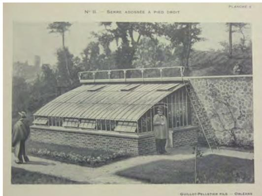
Cette serre mesure 3m40 en largeur intérieure, 7m44 en longueur et comprend bâches fer, tablettes suspendues sur le devant, gradins pour boutures sur l'arrière.
