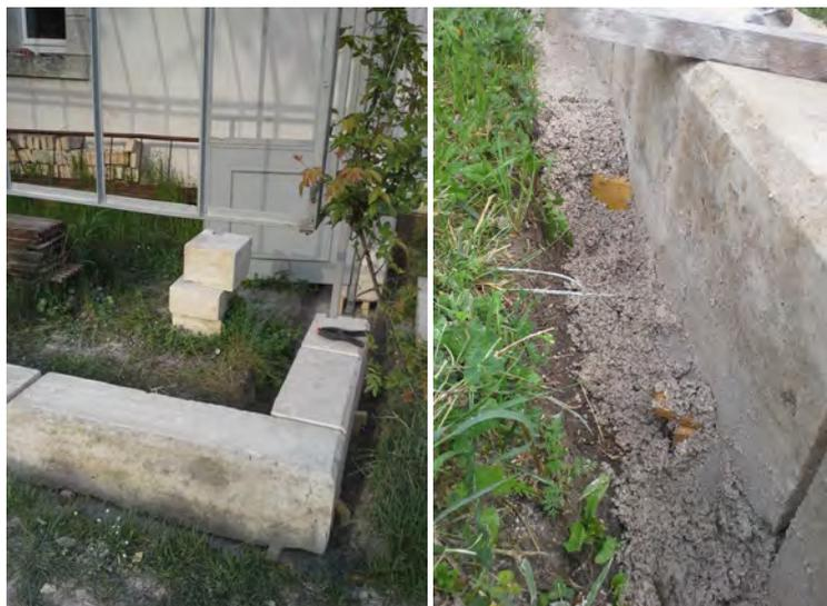
Le muret est reconstruit à partir des pierres et briques d'origine, sauf pour le couronnement réalisé à partir de pierres récupérées sur une autre serre, démontée au cours de l'année 2015.
