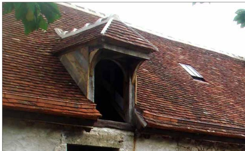
À gauche, noue ancienne (Mareau-aux-Prés). À droite, un bon exemple de réfection de lucarne avec noue arrondie et planches en oblique. À noter le châssis de toit bien intégré à la toiture.
