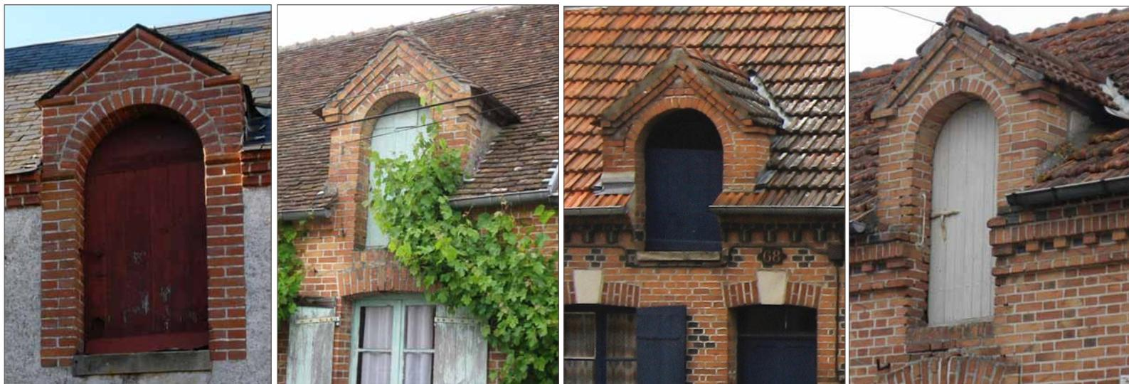
Elles sont évidemment fréquentes en Forêt d'Orléans (sur bâtiments fin XIX<sup>e</sup>) et en Sologne pays de terre cuite. Les linteaux en arc, faciles à réaliser avec des briques, abondent. Les jouées sont en brique et/ou en maçonnerie.
