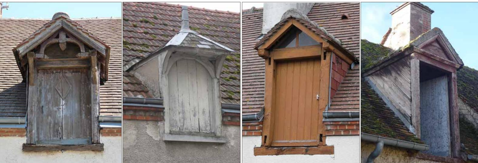
Les parois des "jouées" (côtés) des lucarnes en bois sont traditionnellement réalisées avec des planches posées en oblique, parallèles à la pente du toit.
