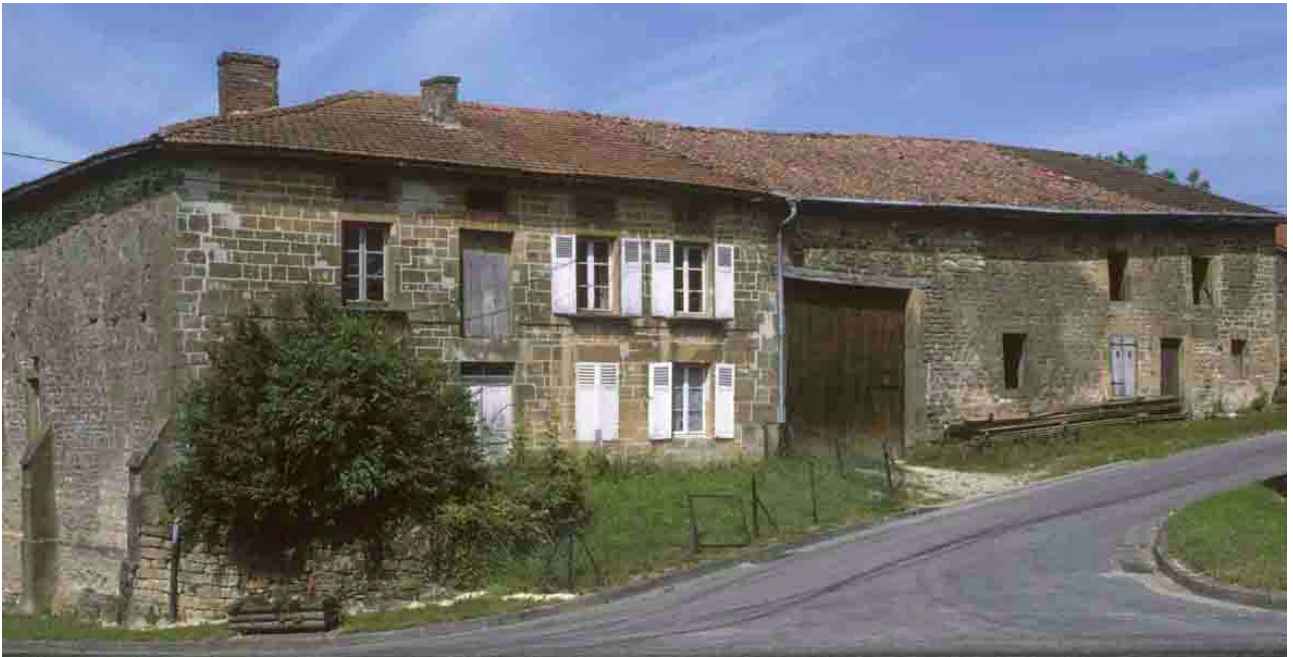
Saint-Pierremont (Ardennes), 1996, grande maison en bloc à terre, à vaste logis, encore partiellement couverte de tuiles néo-romaines.
