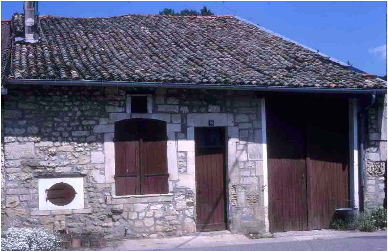
Lavincourt (Meuse), 1998, une maison lorraine touchée par le débordement de la tuile néo-romaine dans l'ouest du département de la Meuse.
