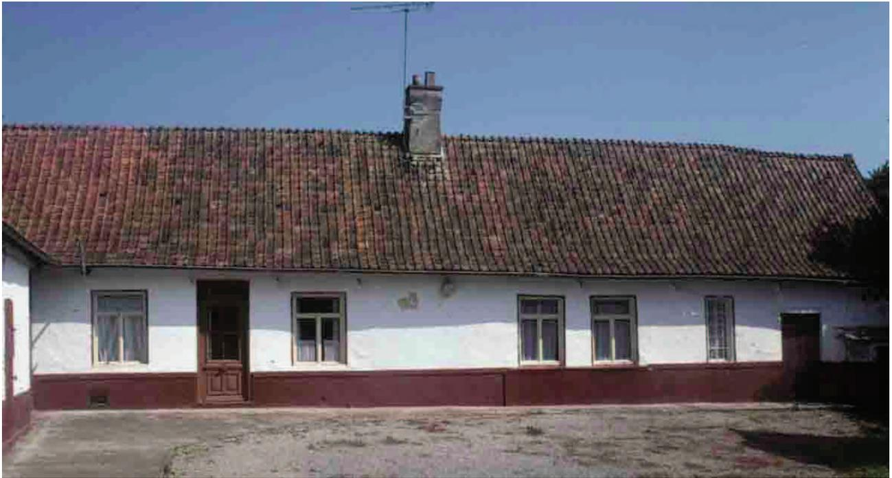
*Verchcoq (Pas-de-Calais), 2003. Ces toitures, amples et pentues, devaient être recouvertes de chaume à l'origine. Une meilleure connaissance de la chronologie des structures de pan de bois, des charpentes et des matériaux de couverture serait bienvenue.*
