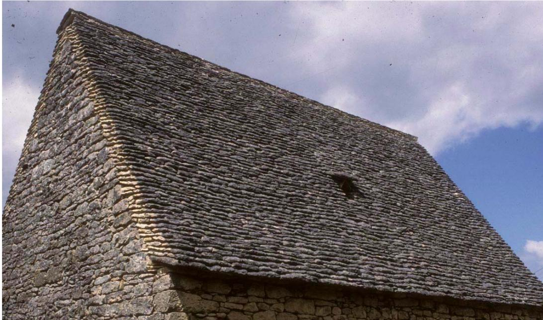
Dans le Quercy, quand les tuiles plates ont remplacé les lauzes, s'est instaurée la coutume de conserver les pierres en rive de gouttereau pour maintenir la poussée vers l'intérieur. Au sud du Quercy, les dalles calcaires, de grande dimension, posées sur gouttereau, servent d'égout aux toitures de tuile canal.
