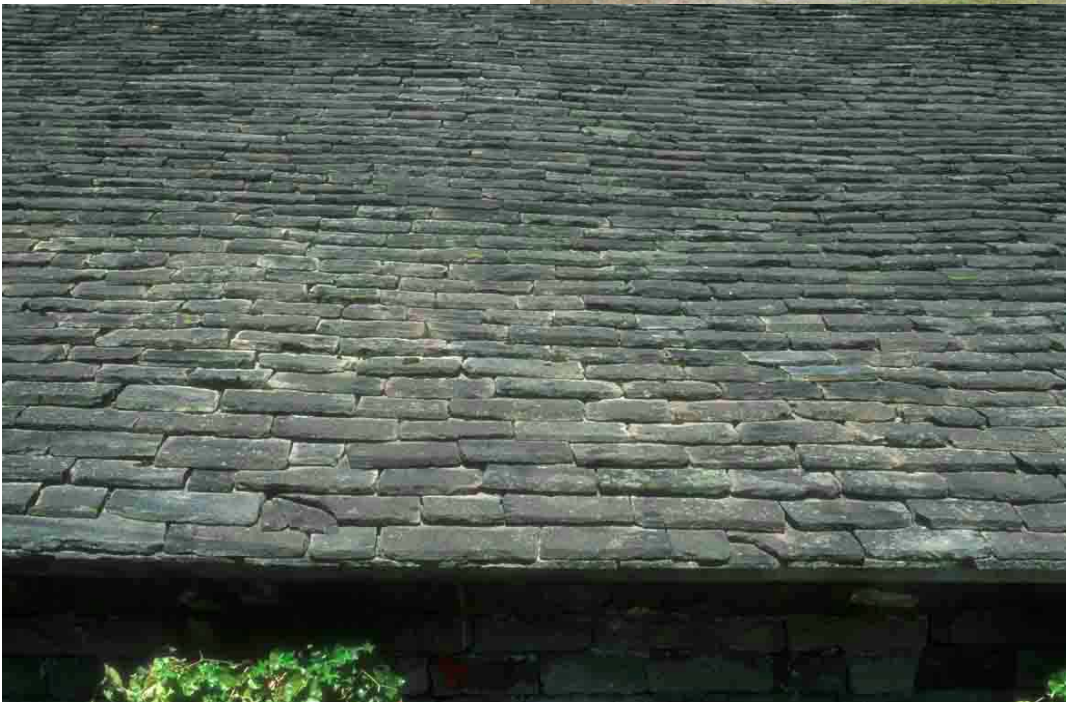
Le Sarcenot (Haute-Saône), 2011. Une toiture bien restaurée, dans le cadre d'une action de sauvegarde des chélots.
