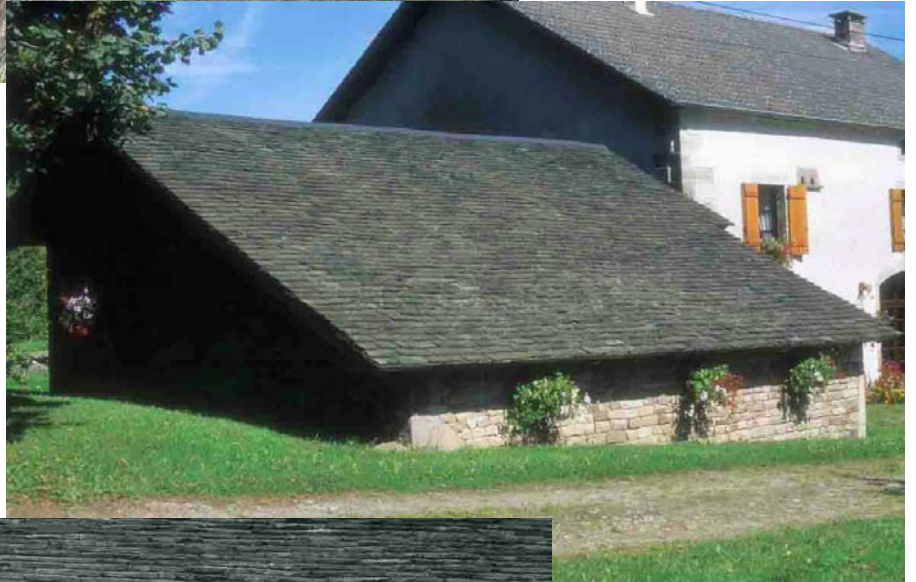
Le Sarcenot (Haute-Saône), 2011. Toiture arrière d'un chélot.
