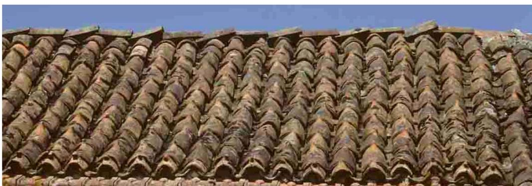
*Auberive (Haute-Marne), sur un toit pentu, les tuiles de coulant sont tenues par un ergot tandis que celles de couvrant buttent les unes contre les autres, grâce à un crochet moulé sur la tuile.*
