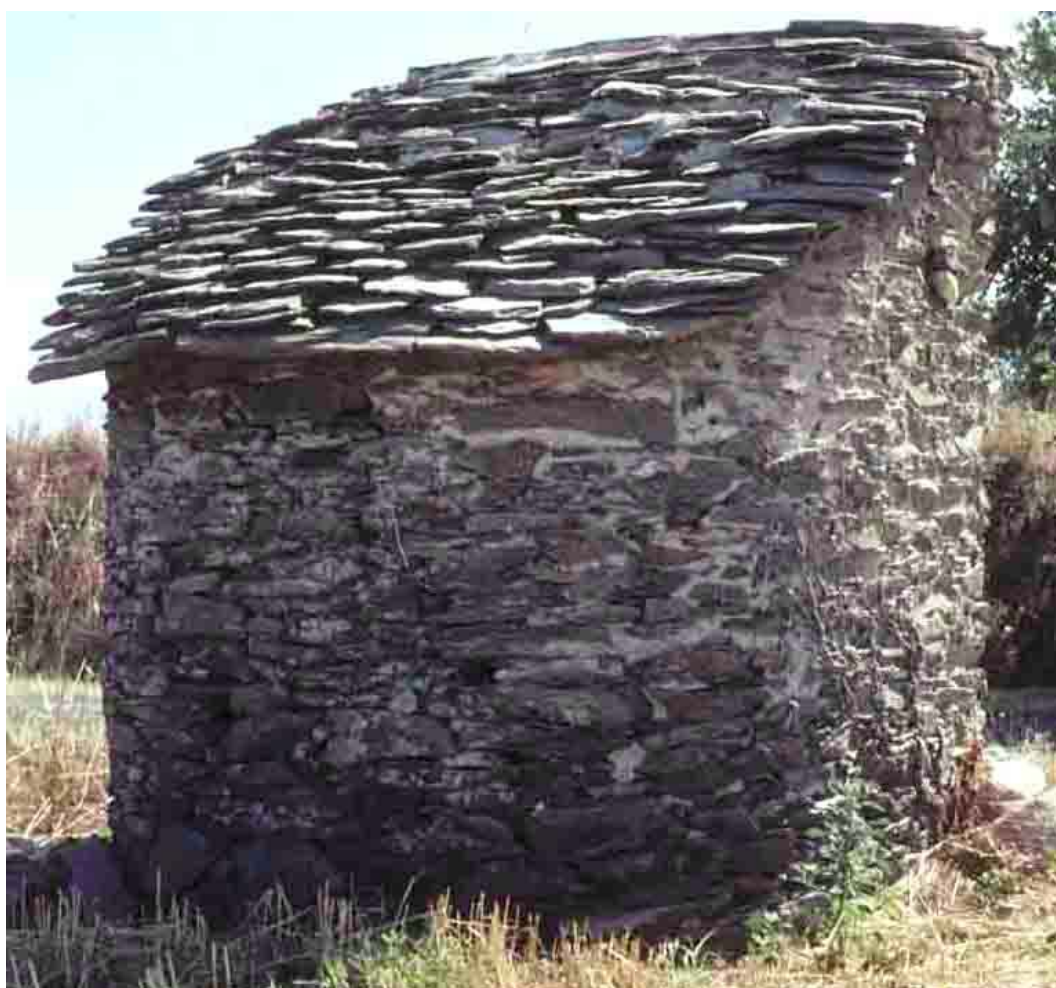
La Calmette (Tarn), 2009. Une exception, dans le Carmausin, que cette toiture de puits, faite de lauzes de schiste.
