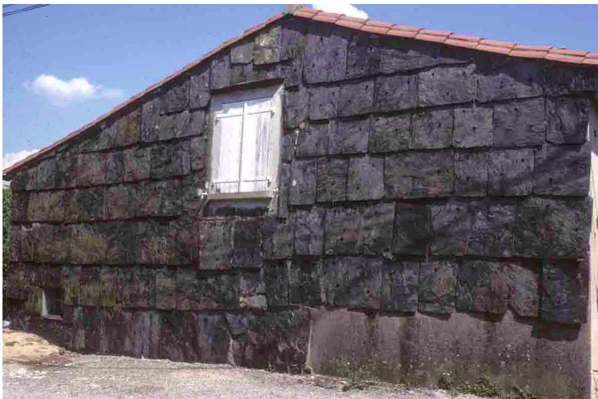
Montfort (Tarn), 1996. Deux à trois clous par ardoise, parfois posés en diagonale.
