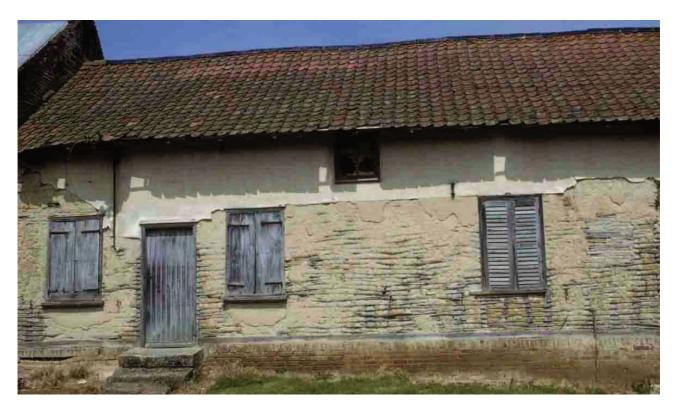
Rogy (Somme), 1994. Cet « écorché » permet de comprendre la technique de recouvrement des pans de bois, à partir d'un lattis cloué serré, sur lequel on applique plusieurs couches de mortier terreux, contenant peu de chaux, sur lesquelles on applique en dernier lieu un lait de chaux.
