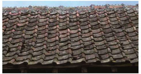
Rogy (Somme), 1994. la tuile d'égout n'est pas doublée, comme avec les matériaux traditionnels. L'emboîtement permet de ménager une grande surface de pureau, ce qui allège le poids de la couverture. Les tuiles faîtières, à poinçons, sont scellées avec crêtes et embarrures.
