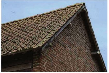
Rogy (Somme), 1994. Ces tuiles à emboîtement sont posées à joints alignés. Le chevron débordant permet aux deux versants de protéger le pignon. Les tuiles de rive sont légèrement débordantes sur le pignon. De même que les tuiles d'égout, faiblement relevées, débordent de quelques centimètres de la chanlatte.
