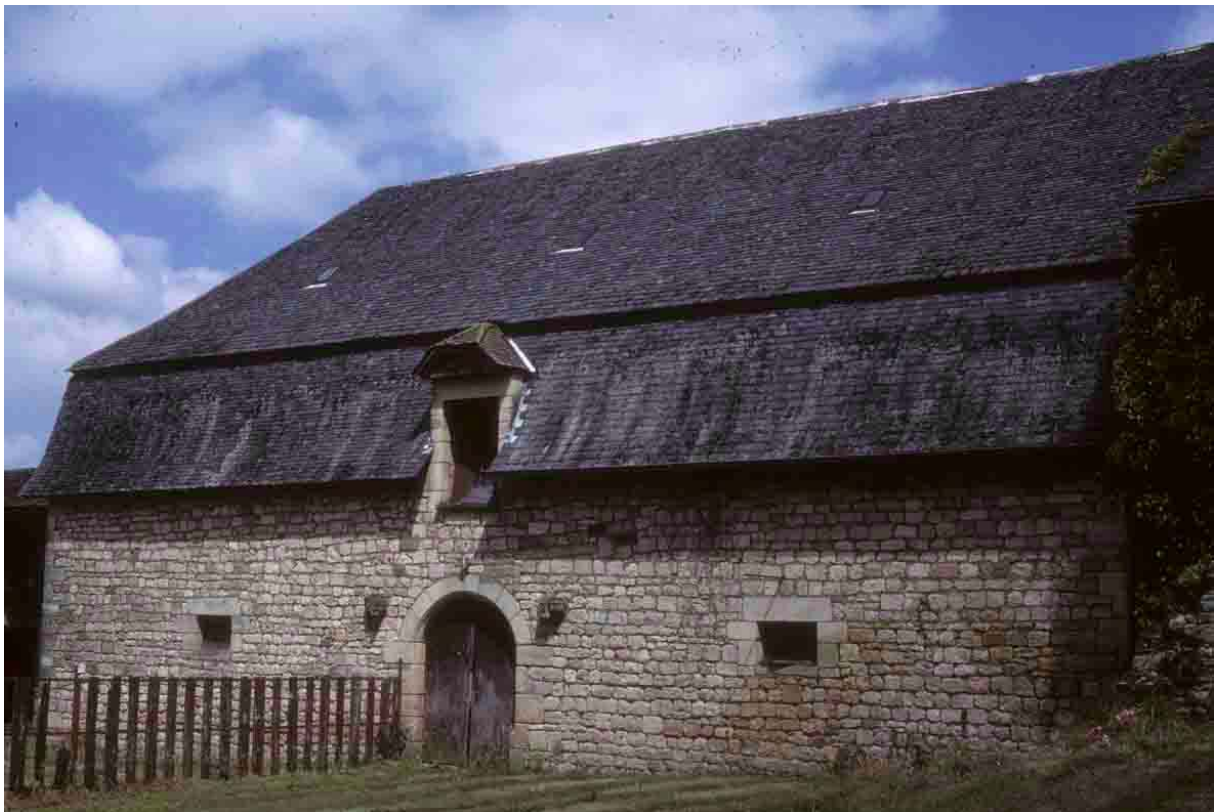
Ayen-Bas (Corrèze), 1994, toit à la mansarde, avec brisis et terrasson couverts d'ardoise.
