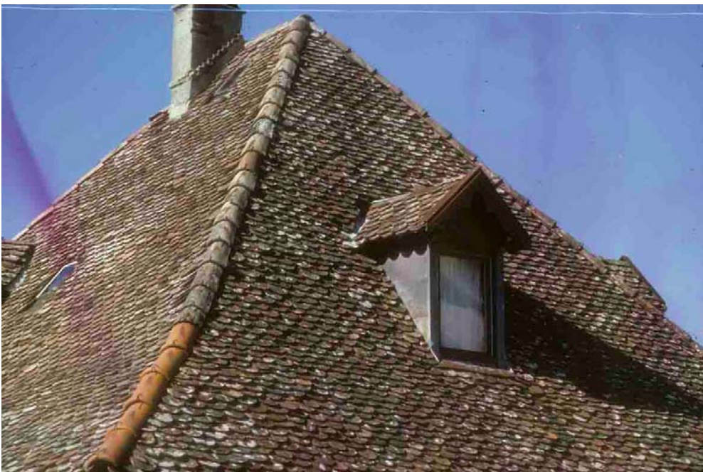
Saint-Pierre-de-Chartreuse (Isère), 1994. arêtiers en tuiles creuses.
