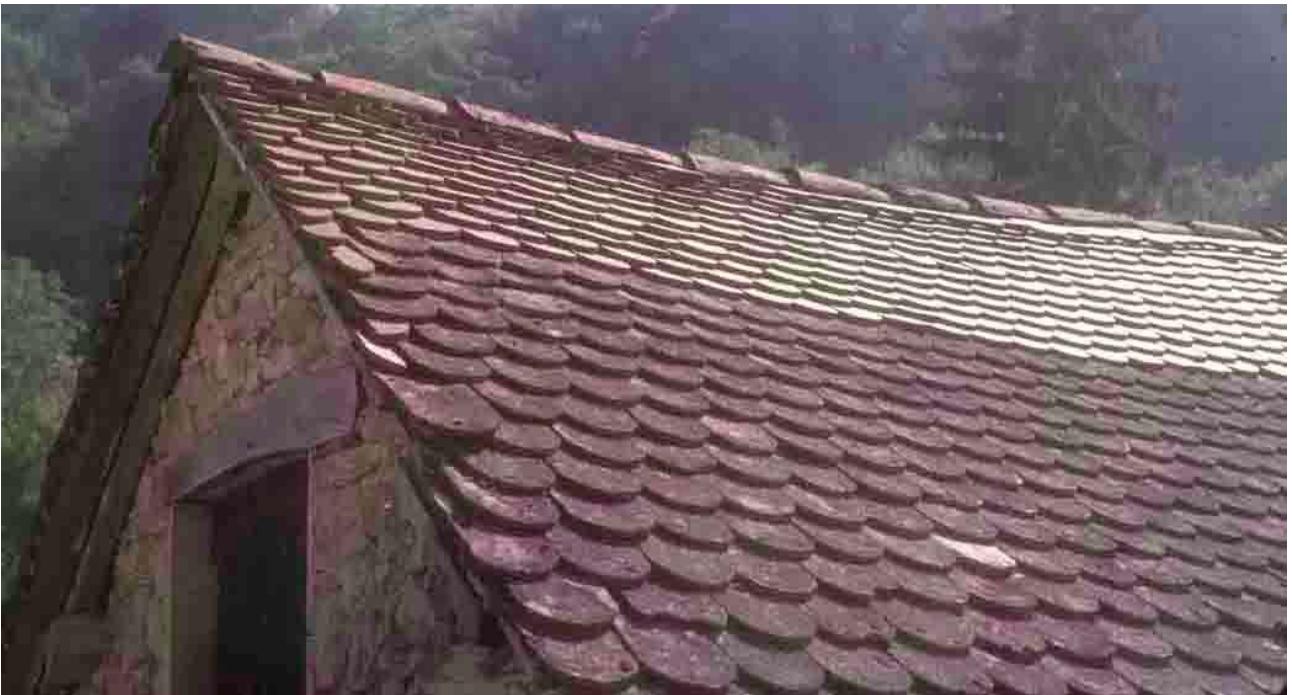
Quaix (Isère), 1994, la rive est logiquement faite de tuiles entières et de demi-tuiles alternées d'un rang à l'autre.
