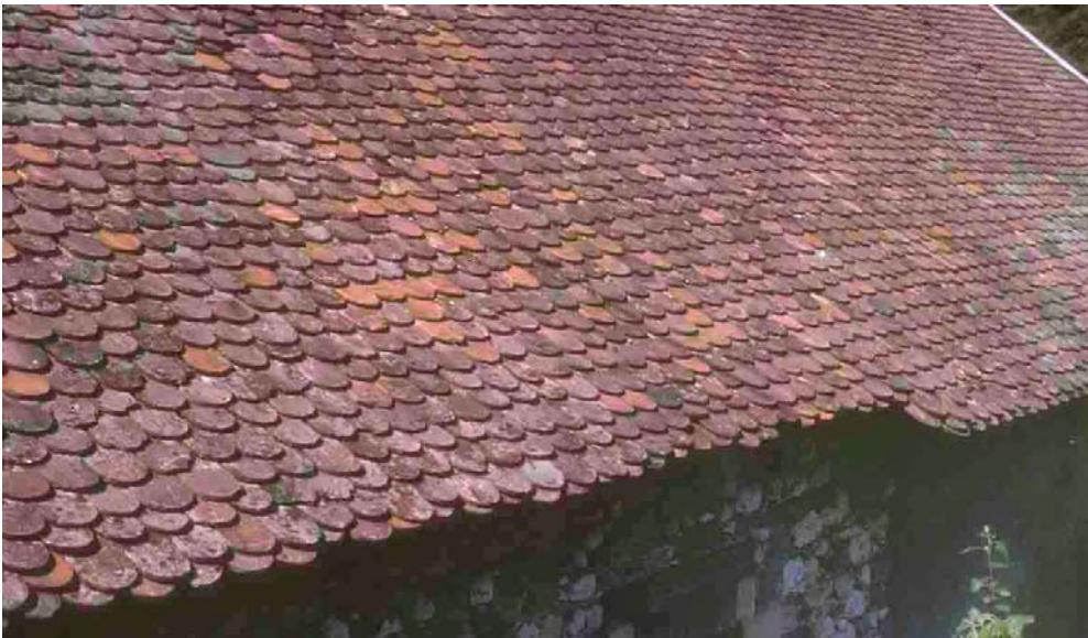
Quaix (Isère) 1994, égout constitué d'un demi-rang de tuiles, permettant de démarrer le croisement des joints.
