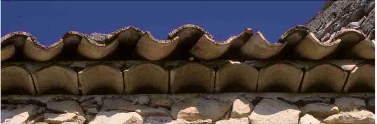
*Dans le sud de la France, l'égout de la toiture repose sur une génoise, consistant en une corniche de tuiles creuses posées en couvrant. Il paraît qu'à Gênes, cette disposition n'existe pas ! Montsalier (Alpes-de-Haute-Provence), 1994, génoise à rang unique.*
