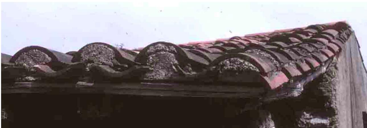
*Les Raynauds (Tarn), 1994. En égout, tuiles de coulant débordantes et tuiles de couvrant maçonnées. En rive, double rang de tuiles de couvrant.*
