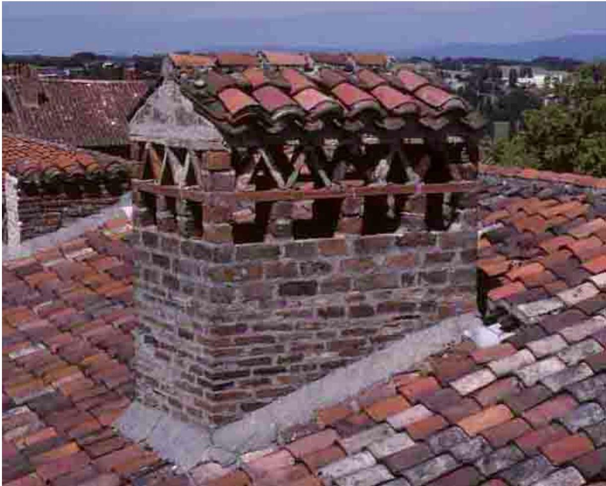
*Pérouges (Ain), 1998, souche en brique, surmontée de jours en briquettes et en tuileaux, recouvertes de tuiles creuses.*
